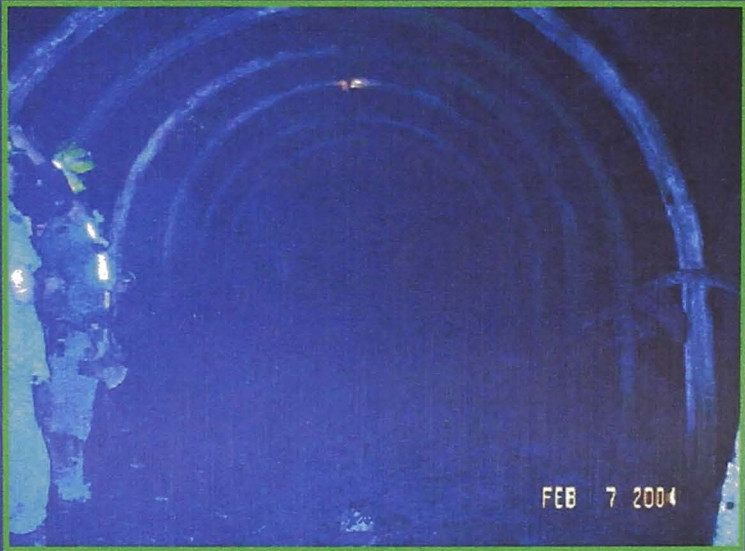
Sostenimiento con cimbra
