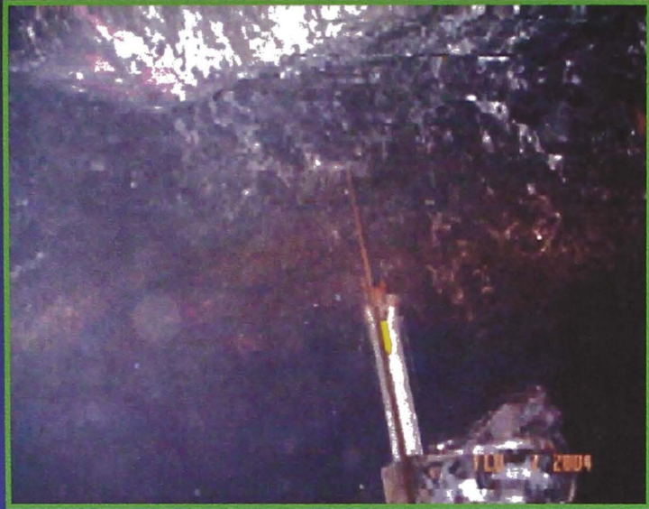
Sostenimiento con pernos
