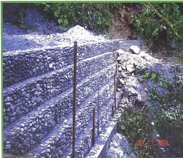
Construcción de Gaviones Uncushito
