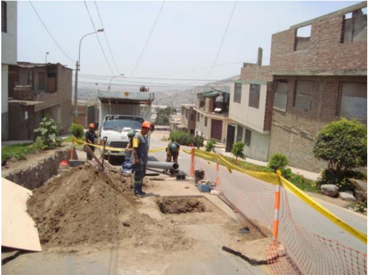
Foto N° 62 Se ve a la contratista solucionando una emergencia provocada por una tubería de agua, se encuentran bien señalizado el trabajo.
