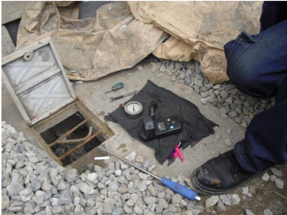
Foto N° 67 Operario con instrumentos para medir el cloro
