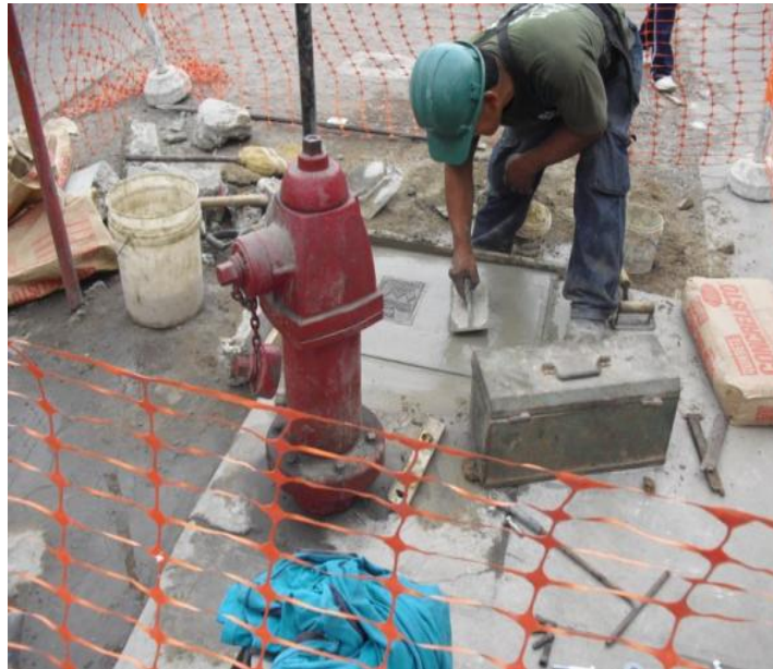
Foto N° 38 Pulido de Losa
