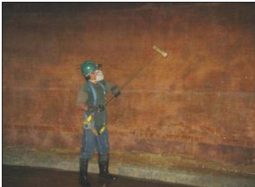
LIMPIEZA DE CUBA INFERIOR EN EL RESERVORIO RP-3
