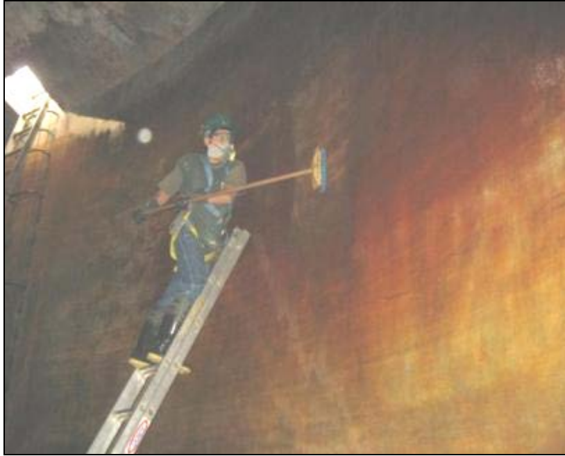
LIMPIEZA DE CUBA INTERIOR PARTE ALTA EN EL RESERVORIO RP-3
