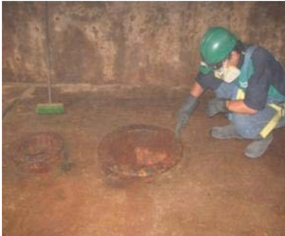
Foto N° 15 LIMPIEZA DE TUBERIA DE ADUCCION SIN CANASTILLA R-18
