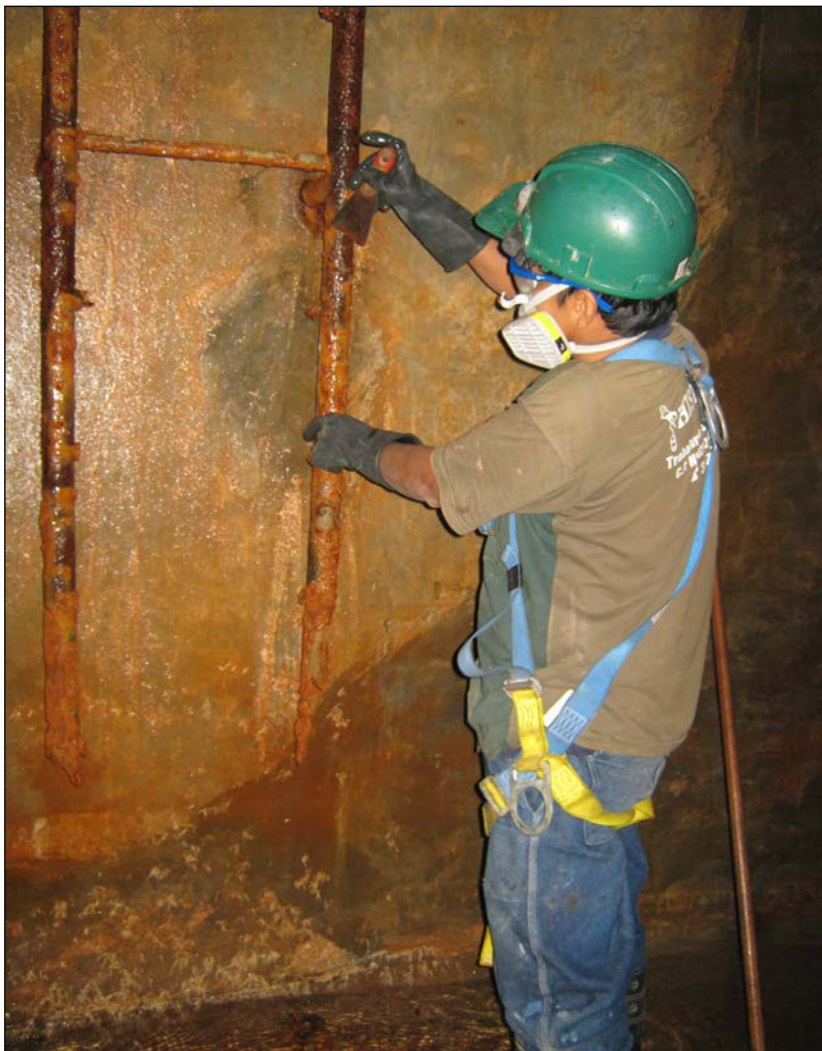
Foto N° 53 Pintado de escalera de reservorio
