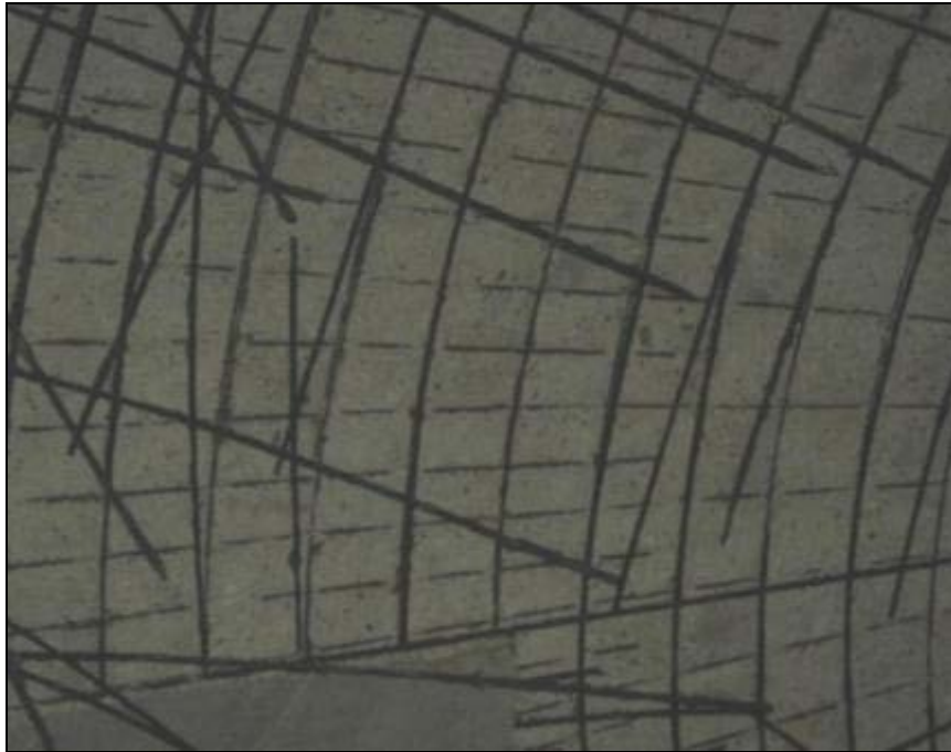
TECHO INTERIOR EN ESTADO CRITICO, SE APRECIA ARMADURA SUSPENDIDA POR DEGRADAMIENTO EN LA LOSA DE CONCRETO DEL R-14
