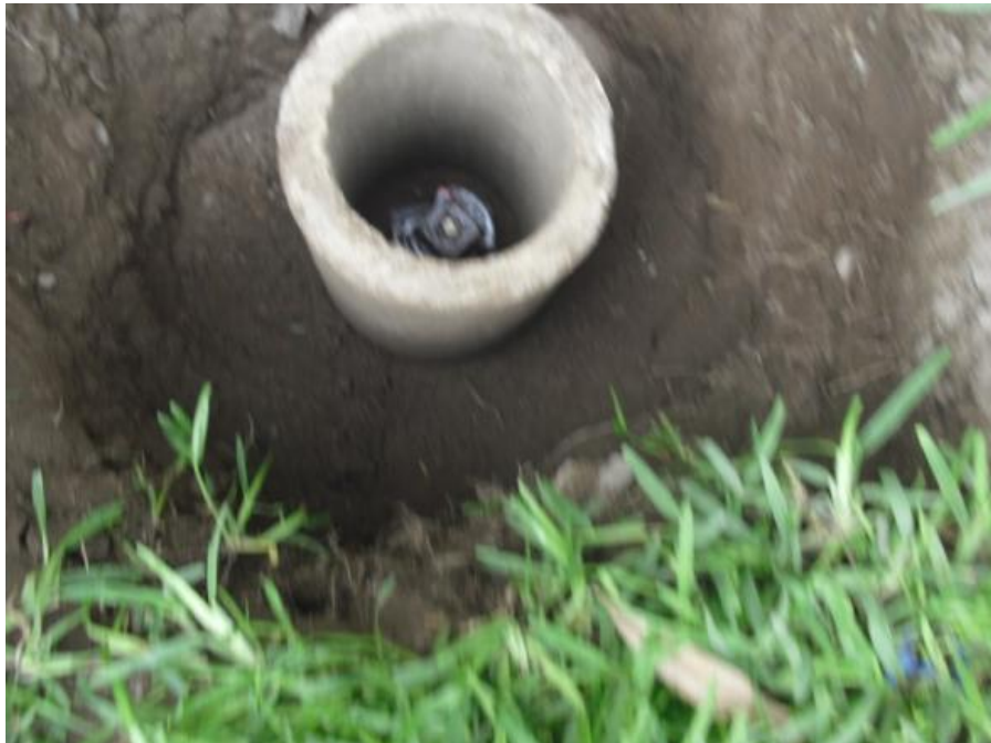
Foto Nº 45 Cambio de empaquetaduras de válvulas
