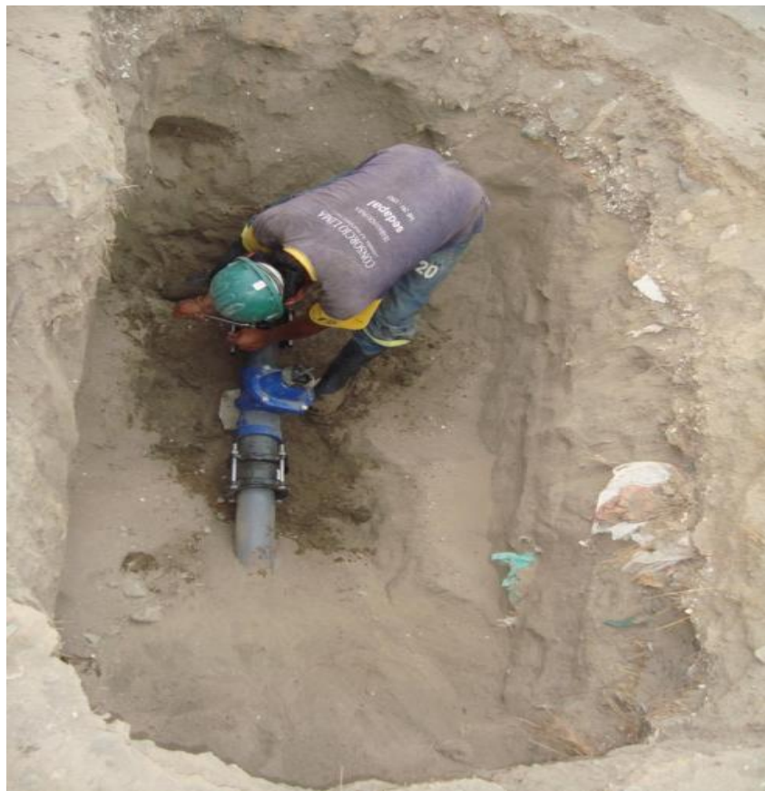
Foto N° 34 operario culminando la reparación hidráulica de la tubería averiada.
