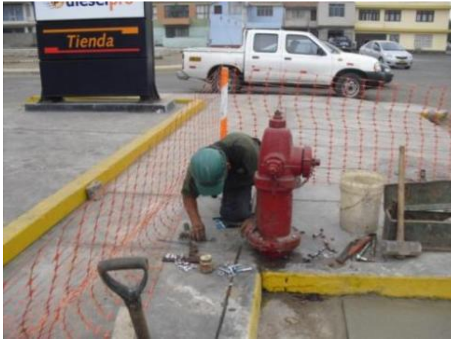
Foto N° 08 Cambio de los pernos de la brida del grifo contra incendio
