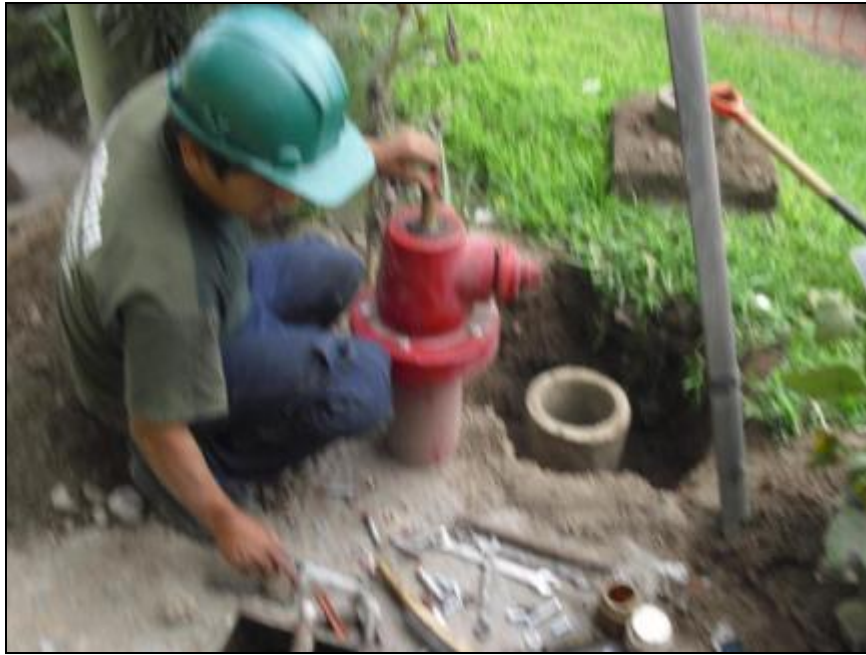
DESMONTAJE DE CABEZAL DE GRIFO CONTRA INCENDIO.
