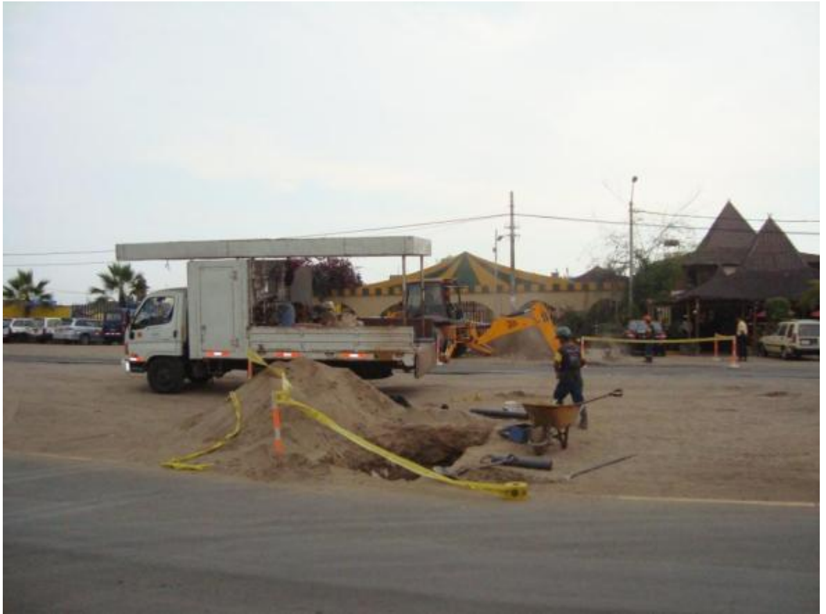
Foto N° 58 Se observa en el campo en dos puntos distintos a la contratista atendiendo las 2 emergencias ocurridas, se le ve con su acertada capacidad logística.
