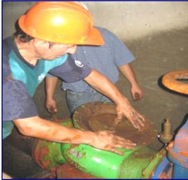
Foto N° 06 Desgaste de los componentes de la válvula
