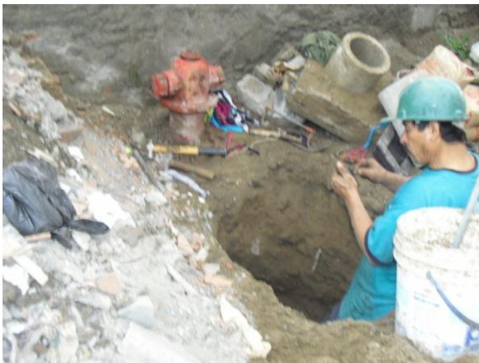
Foto N° 42 Mantenimiento menor de válvula
