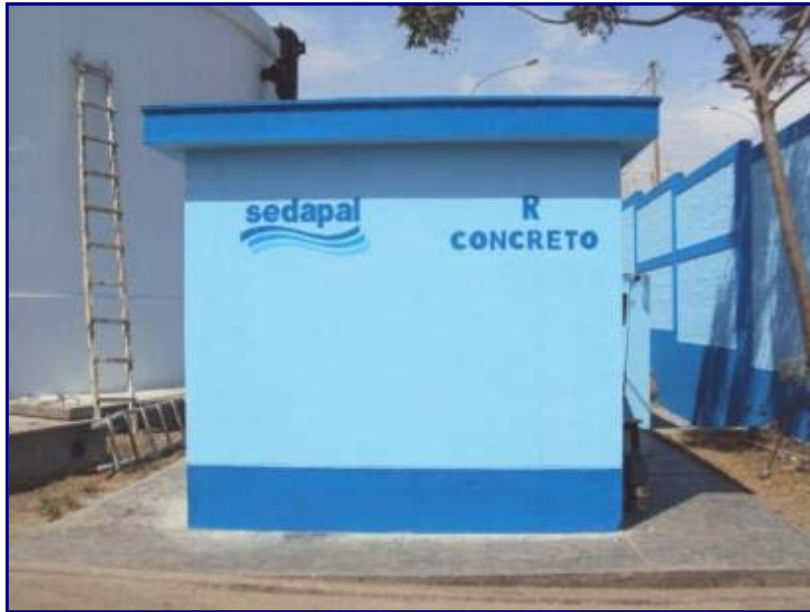
Foto N° 52 Pintado estructura de almacenamiento
