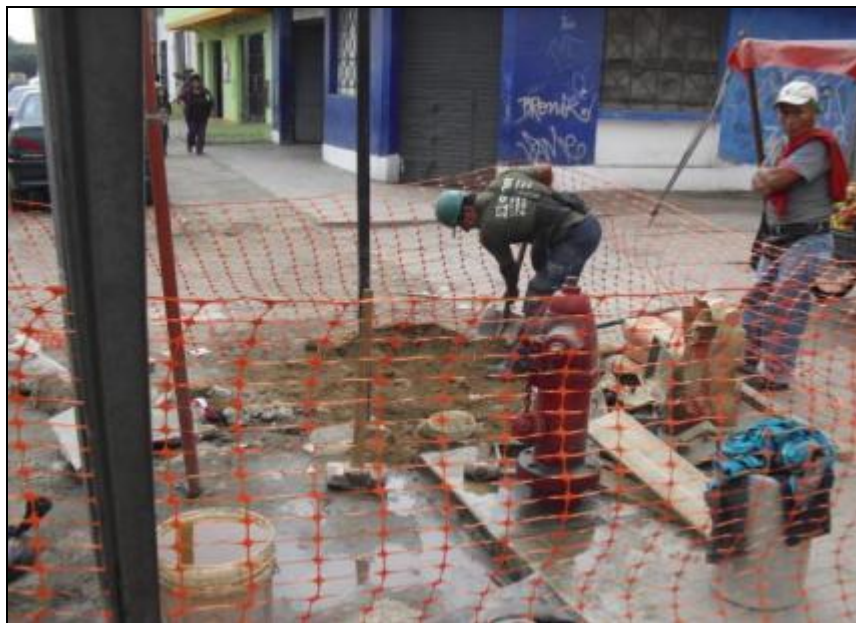
TRABAJOS DE MANTENIMIENTO DE VÁLVULAS DE GRIFO CONTRA INCENDIO.
