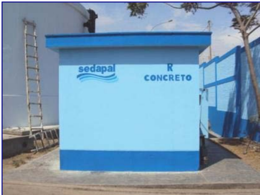
Foto N° 25 PINTADO DE CASETA DE CONTROL
