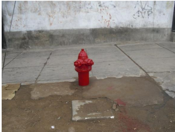
Foto N° 44 Pintado de grifo contra incendio
