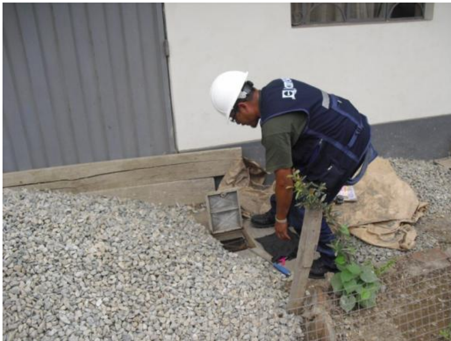
Foto N° 40 Operario tomando la presión del agua
