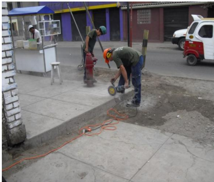
Foto N° 37 Corte de vereda con amoladora
