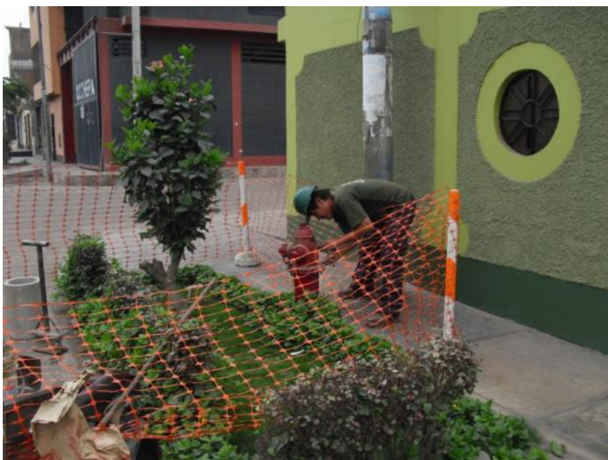
Foto N° 47 Mantenimiento mayor de grifo y mantenimiento menor de válvulas
