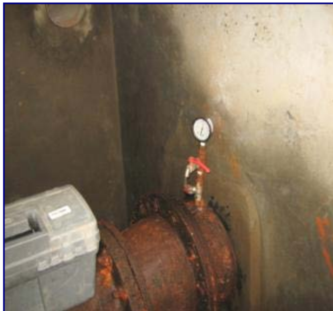
Foto N° 05 Desgaste de los componentes de la válvula
