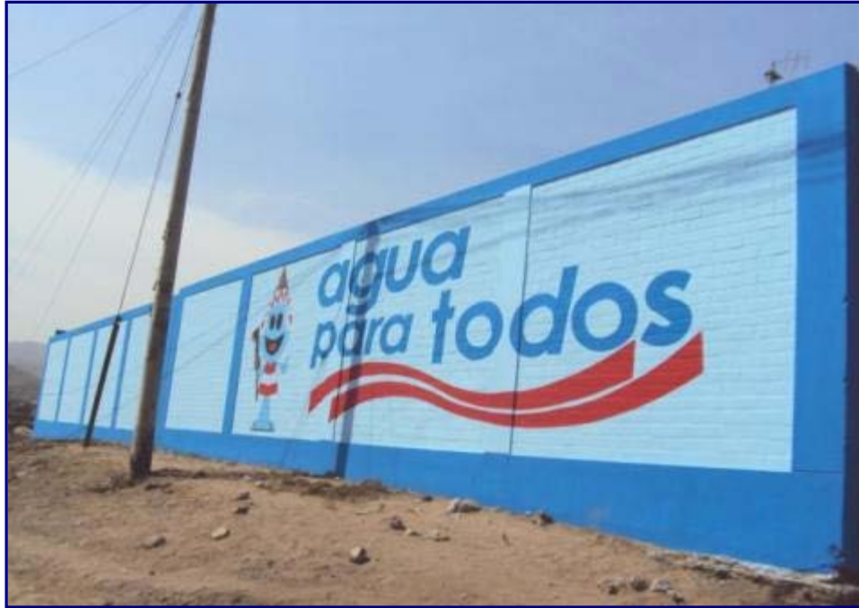
Foto N° 26 PINTADO DE CASETA DE CONTROL
