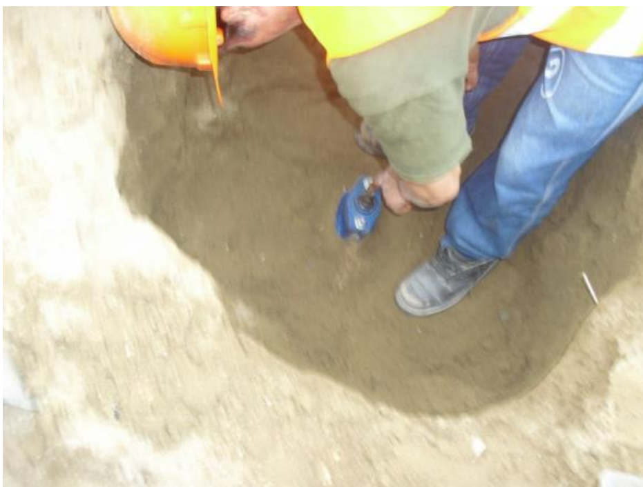
Foto N° 46 Mantenimiento preventivo sistema de válvulas
