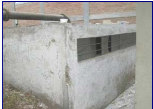
Foto N° 20 CASETA DEL RESERVORIO
