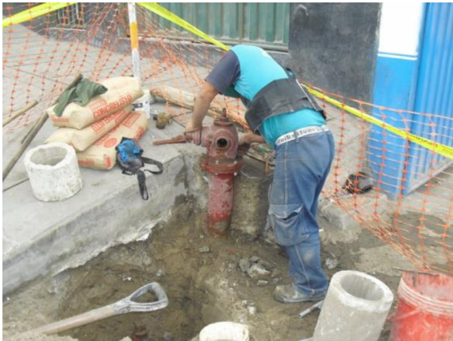
Foto N° 43 Mantenimiento mayor de grifo contra incendio
