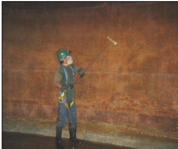
Foto N° 49 LIMPIEZA DE CUBA INFERIOR EN EL RESERVORIO RP-3
