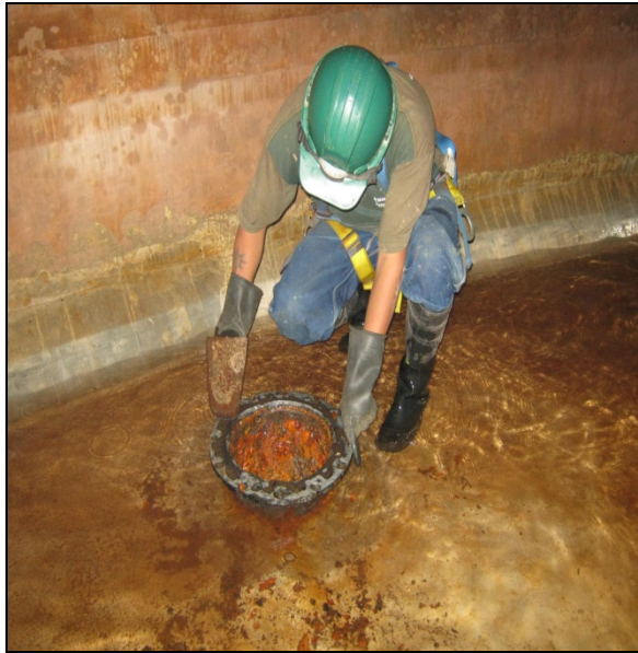
Foto N° 50 LIMPIEZA DE TUBERIA DE ADUCCION CON OXIDO Y SIN CANASTILLA EN EL RESERVORIO RP-3
