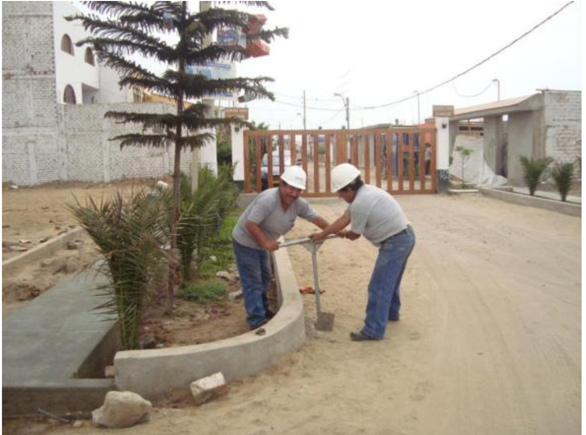
Foto N° 61 Se operando la válvula a valvuleros de SEDAPAL
