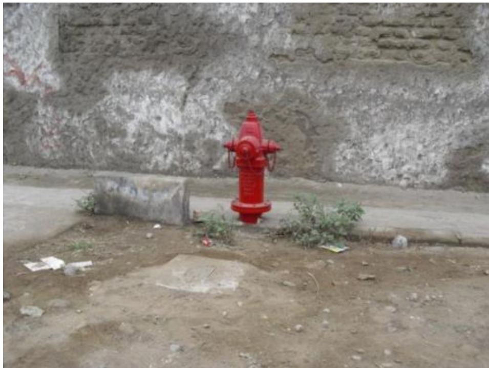
Foto N° 09 Grifo contra incendio terminado
