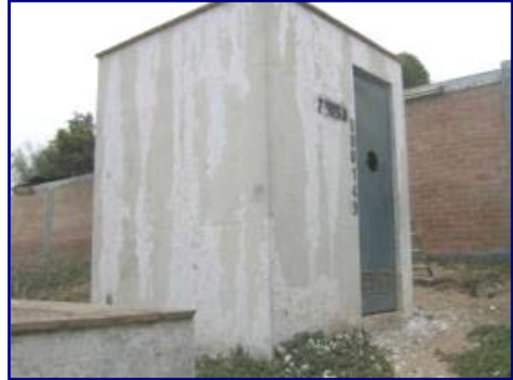
Foto N° 22 CASETA DE CONTROL ELECTRICO
