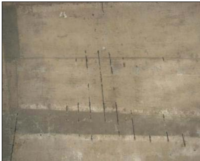
TECHO INTERIOR EN ESTADO CRITICO, SE APRECIA ARMADURA SUSPENDIDA POR DEGRADAMIENTO EN LA LOSA DE CONCRETO DEL R-14
