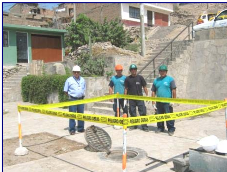
Foto N° 07 Ingeniero residente con los operarios antes de efectuar un mantenimiento de una cámara reductora de presión
