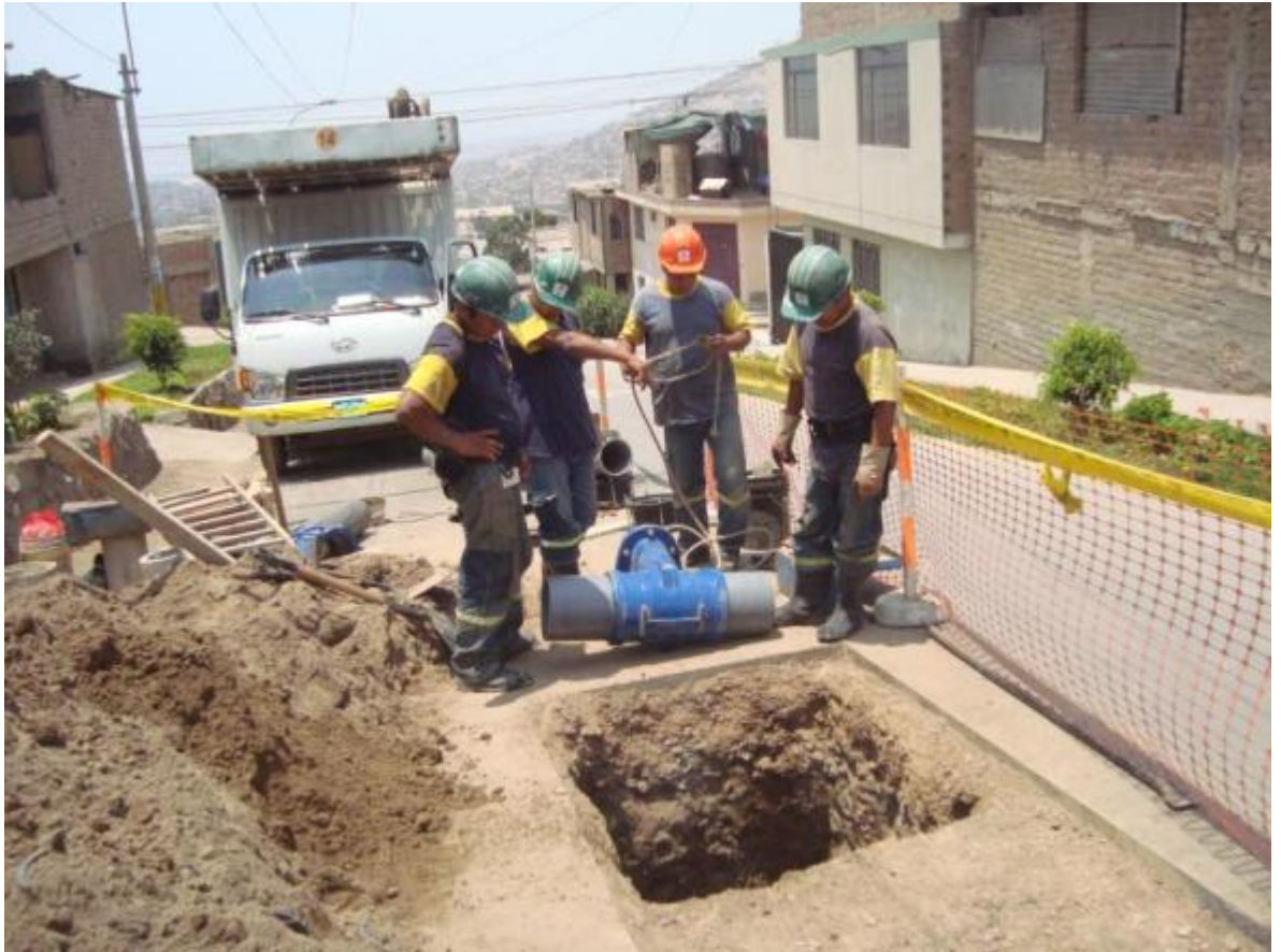
Foto N° 63 Operarios están reparando parte de la tubería con un accesorio
