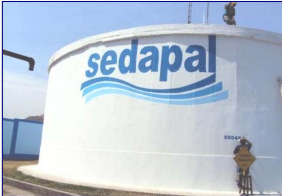
Foto N° 24 PINTADO DEL RESERVORIO APOYADO
