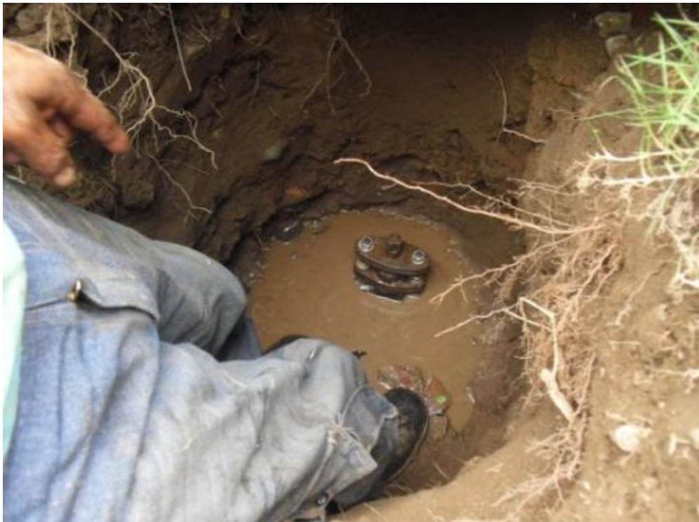
Foto N° 03: Cambio de pernos del portaclan
