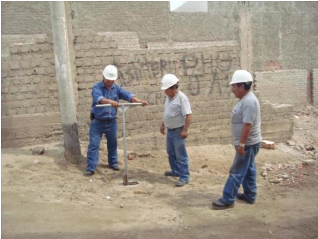
Foto N° 65 Se ve al personal de SEDAPAL manipulando las válvulas para cerrar un circuito a fin de mejorar la presión en dicho sector, ya que van a cambiar el diámetro de la tubería Matriz en dicho sector. Como consecuencia del reclamo de la población de tener una baja Presión.
