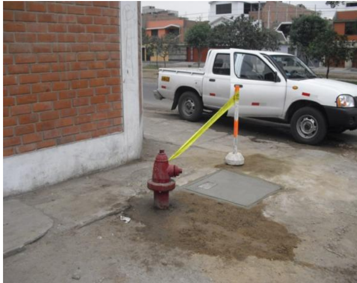
Foto N° 36 resane de losa
