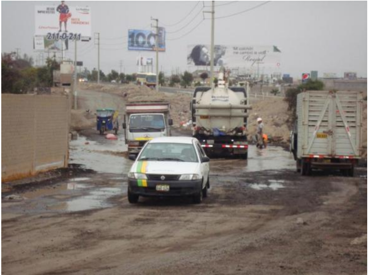
Foto N° 59 Se observa un aniego como consecuencia de una rotura de tubería de desagüe y también ha comprometido a una tubería de agua, incluso SEDAPAL inmediatamente se apersonó y es donde el Ingeniero de SEDAPAL comienza a llamar vía nexte I al Ingeniero residente de la contratista a fin de que solucione el aniego en la brevedad del tiempo, como consecuencia de esta llamada, el personal de la contratista tiene que atender esta emergencia incluso dejando de trabajar en otros puntos que no tienen la debida importancia a fin de evitar una multa.
