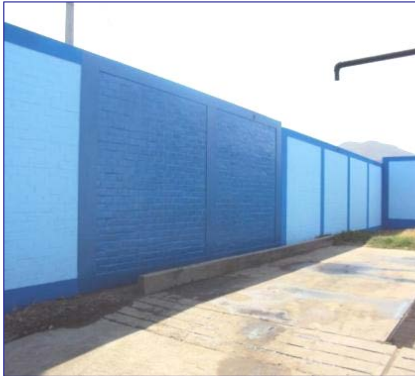
Foto N° 51 Pintado de Cerco perimétrico
