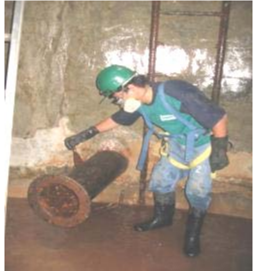
Foto N° 18 LIMPIEZA DE TUBERIA DE ADUCCION SIN CANASTILLA RP-10
