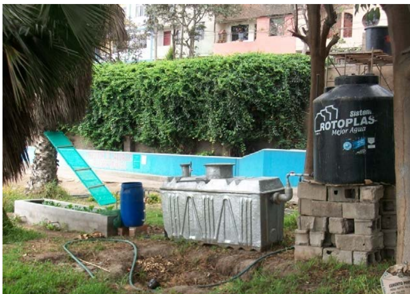
Foto N° 1 Ubicación de la planta de tratamiento piloto
