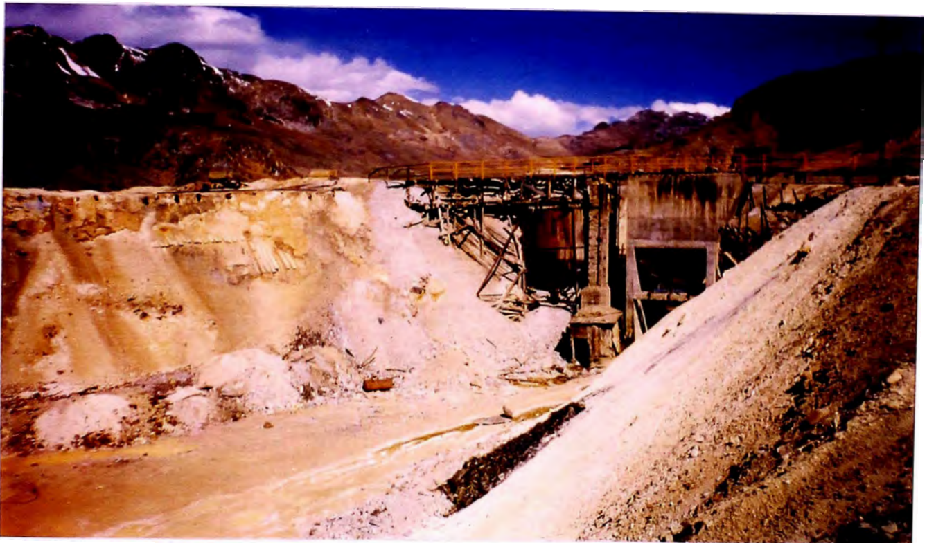
Foto N° 6: El mismo botadero de desmonte, donde se observa la tolva de carguío a camiones y accesos.
