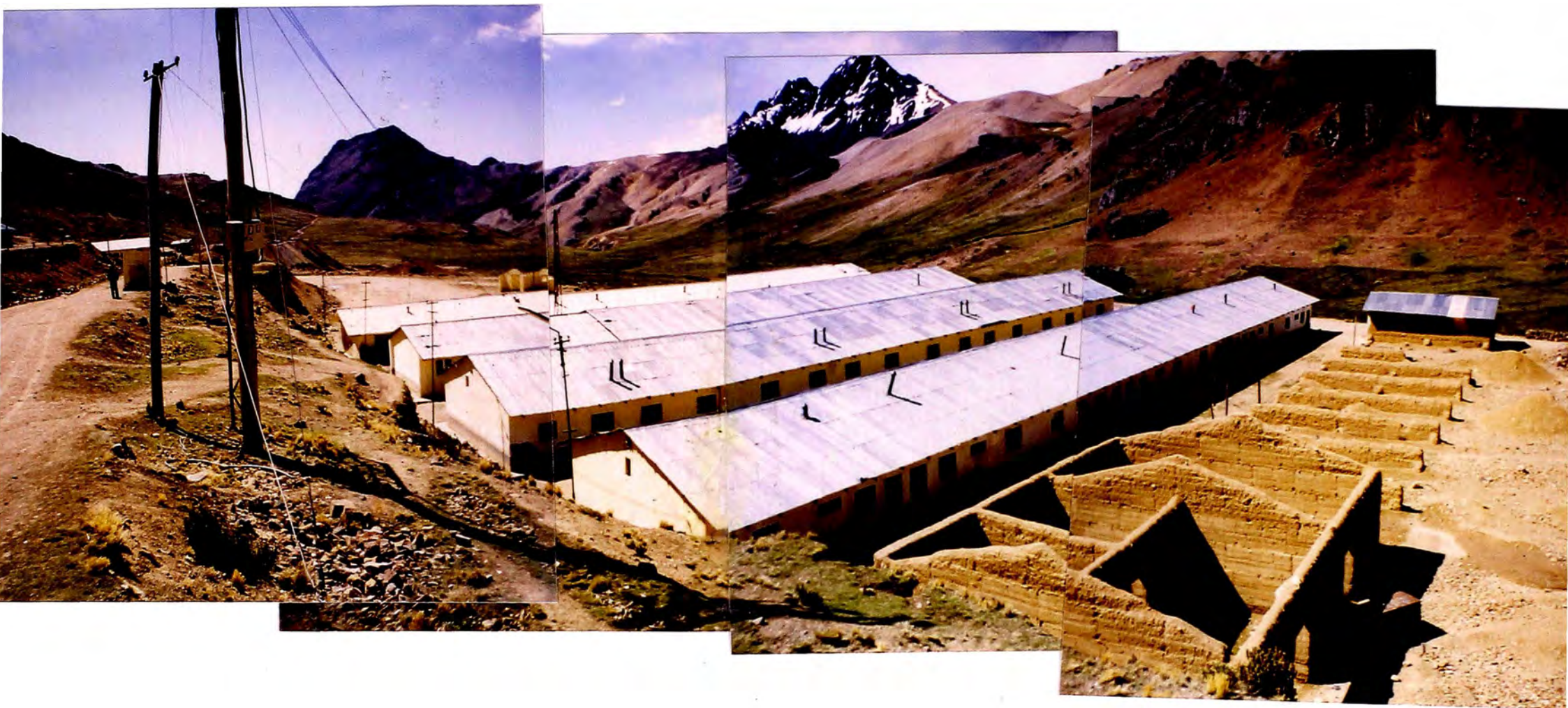
Foto Nº 1 :Vista de la Unidad El Palomo, se aprecia las oficinas administrativas, campamentos de empleados y carretera hacia Recuperada, entre otros componentes de la unidad.
