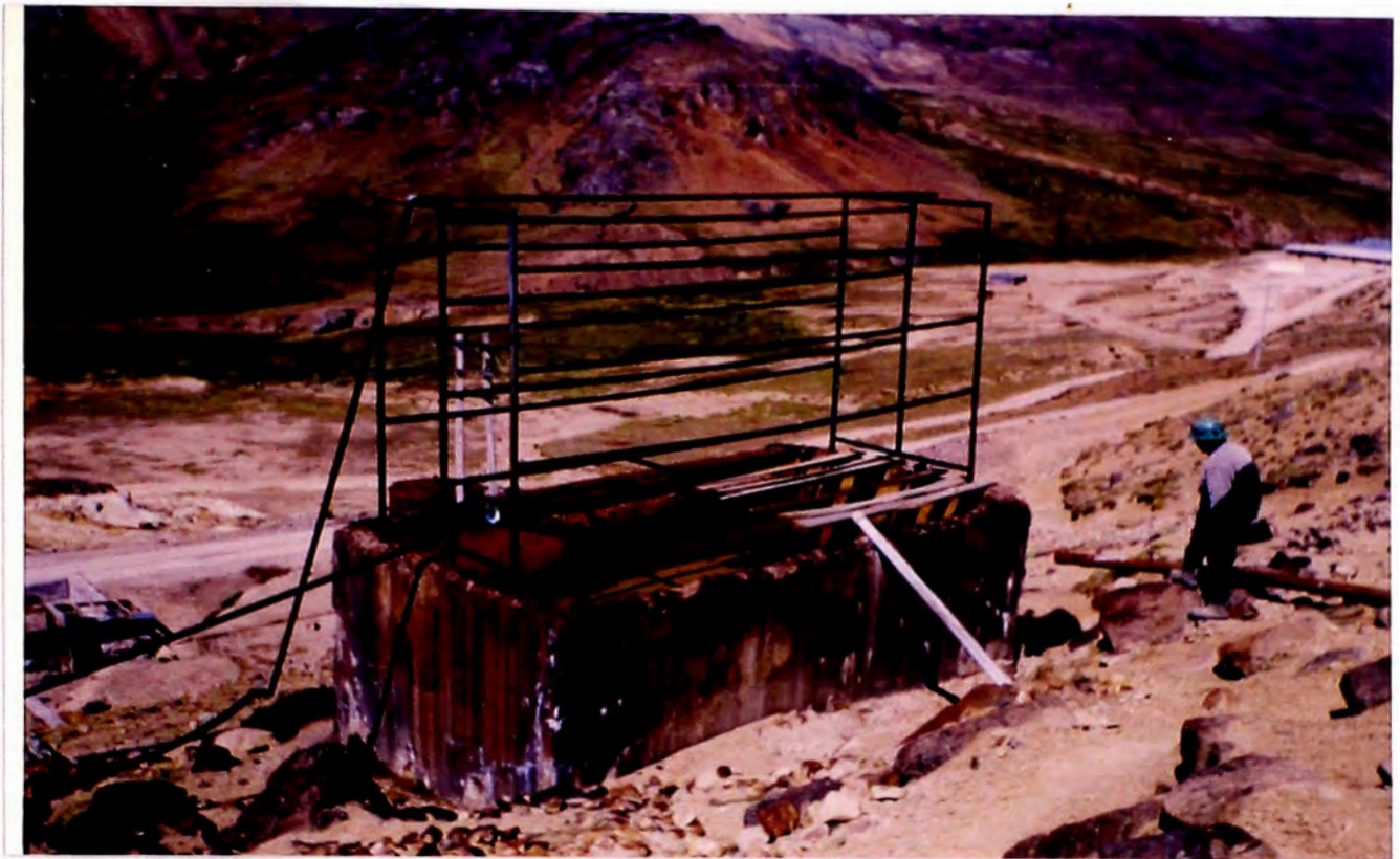
Foto N° 7 : Reservorio de concreto para agua de perforación con una capacidad de 55 m 3
