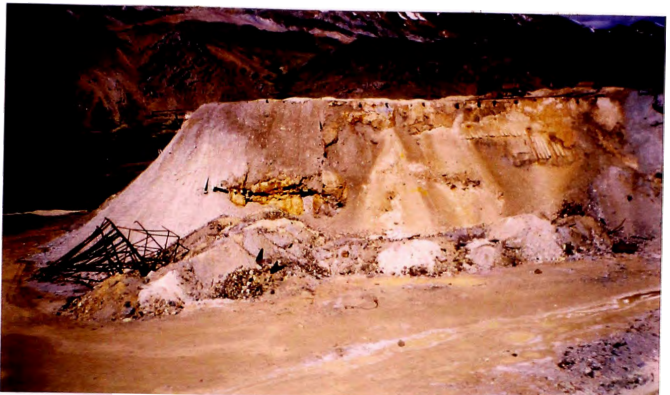
Foto N° 5 :Botadero de desmonte (Nivel 720) cuyo talud deberá ser rebajado.
