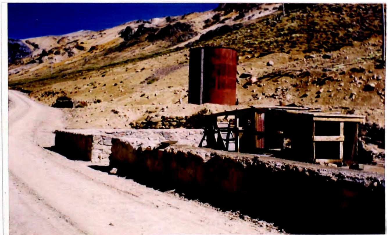
Foto N° 8: Tanque para combustible con una capacidad de 15,500 galones, ubicado a pocos metros de la carretera principal.
