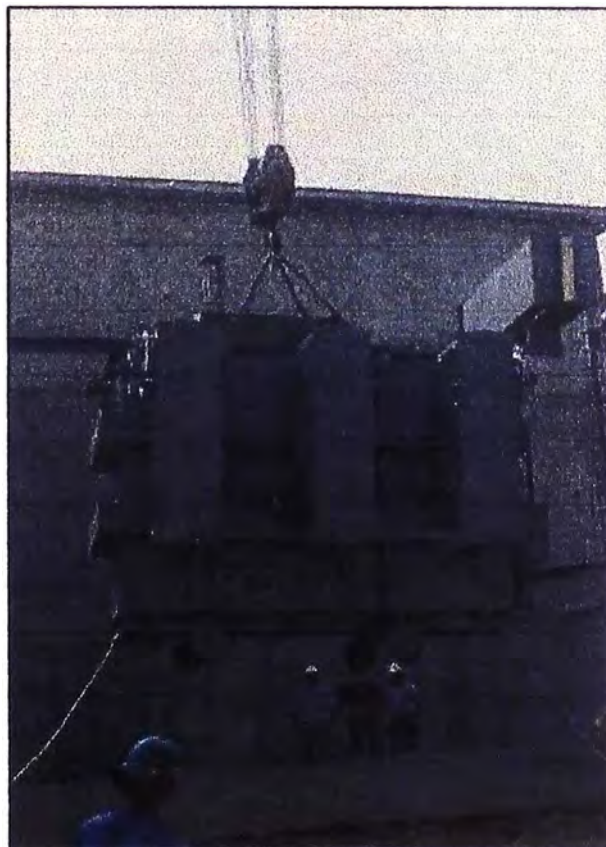
Figura N° 42 Traslado de un Transformador de 18 MVA a su Ubicación Final
