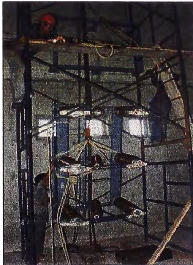
Figura N° 36 Montaje del Seccionador de 60 kV
