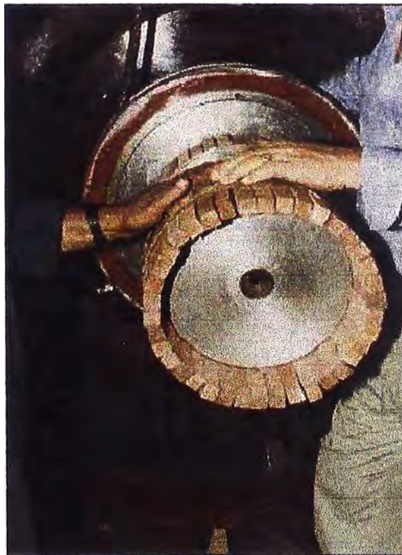
Figura N° 46 Protección del Eje del Generador para levantarlo
