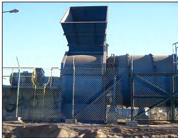
Figura 1.4: Ventilador centrifugo
