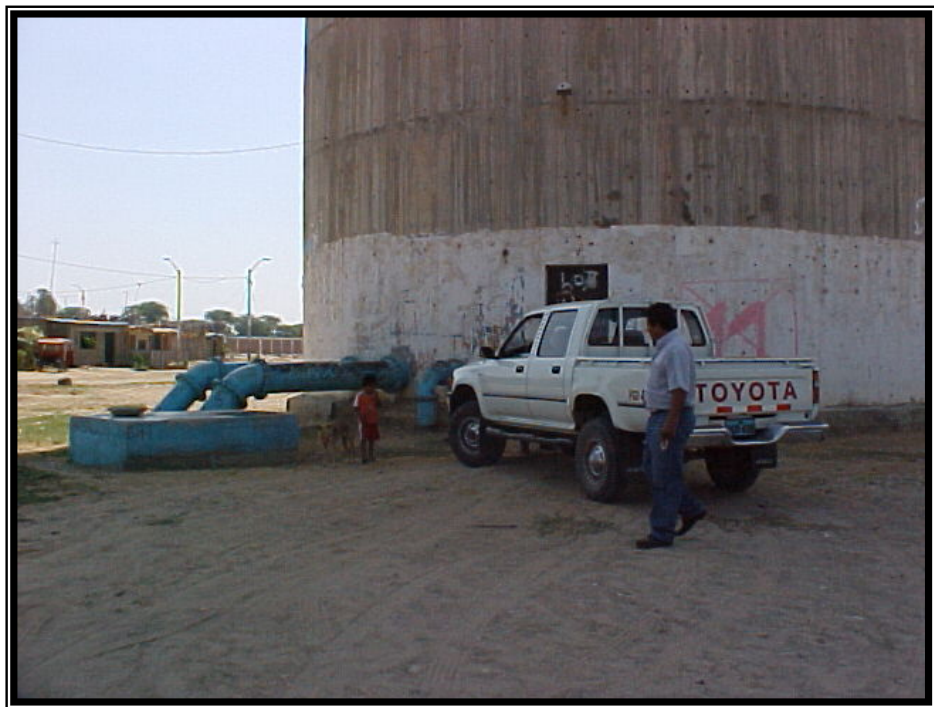
Sistema de Almacenamiento – Acceso al Reservorio Bellavista
