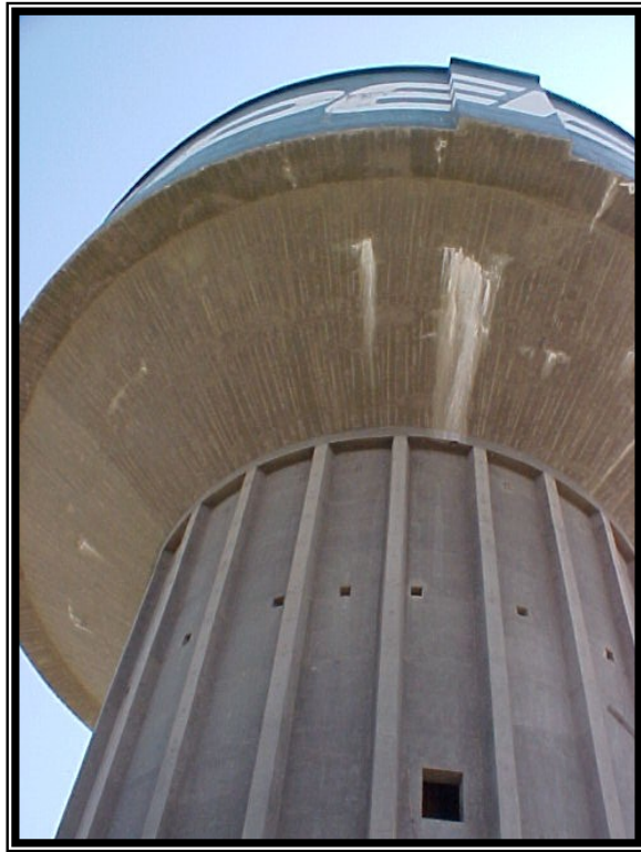
Sistema de Almacenamiento – Reservorio El Mambre V= 4000 \text{ m}^3
