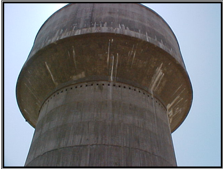
Sistema de Almacenamiento – Reservorio Bellavista V= 3000 \text{ m}^3
