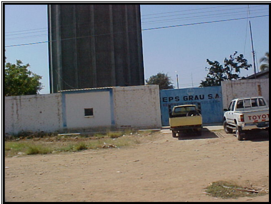
Sistema de Almacenamiento – Acceso al Reservorio Sánchez Cerro
