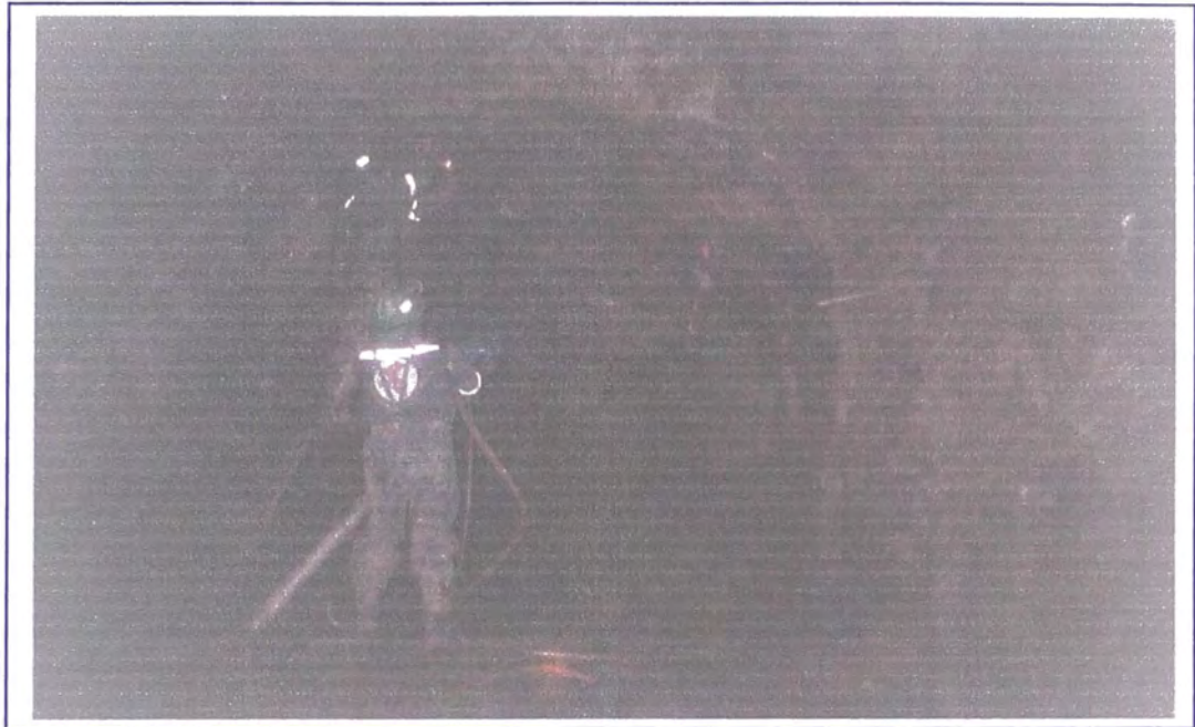
Instalación del split set
