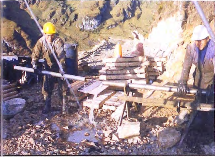
Fotografía N° 16 Extrayendo testigo del tubo triple Herramienta sofisticada que puede extraer panizos material de falla. Al fondo cajas para testigos.
