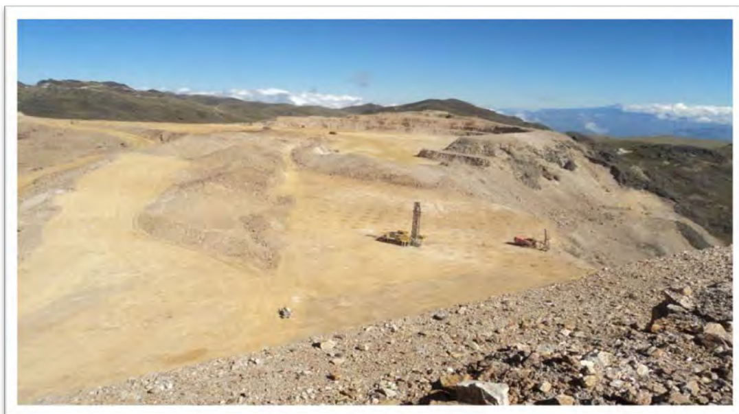
FOTO 3.19: PERFORACIÓN EN EL BCO. 3978 DEL TAJO TANTAHUATAY.
