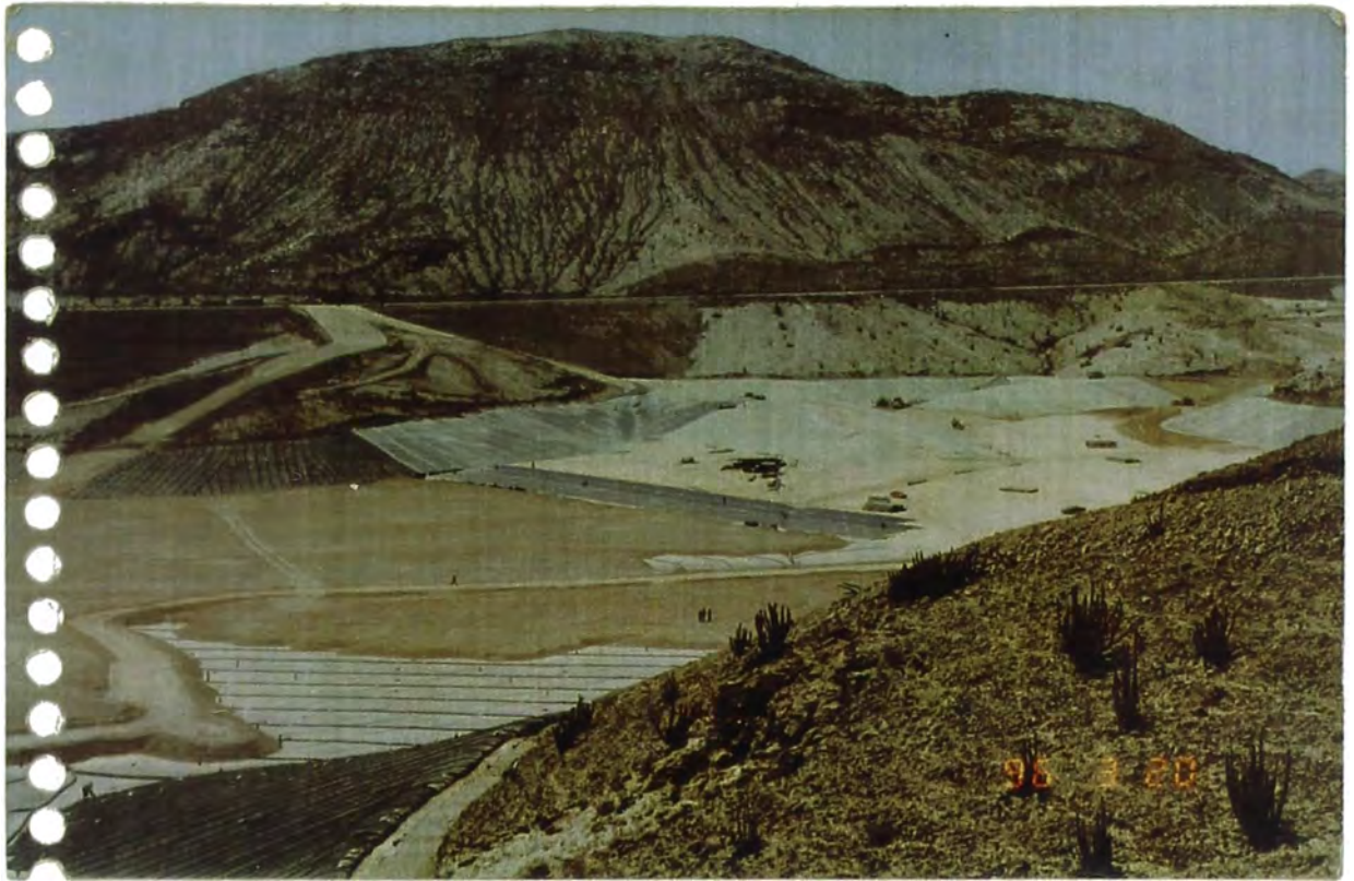
INSTALACION DE GEOMEMBRANA.
