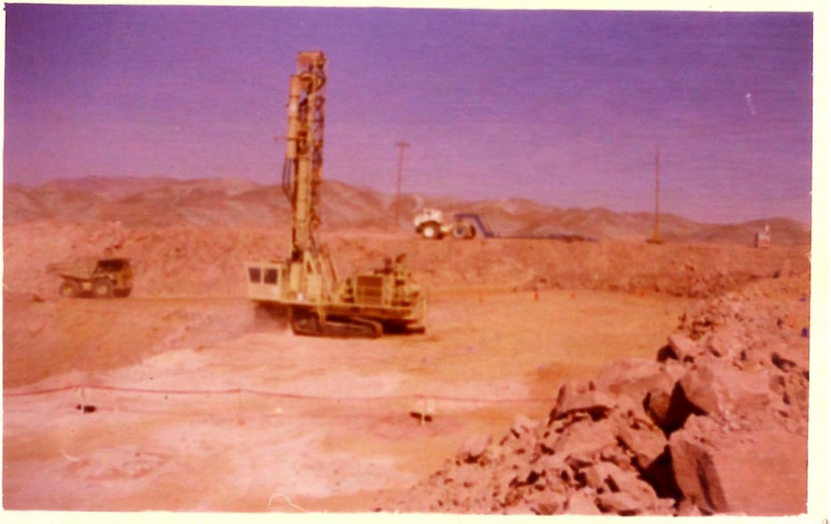
Fig. 13 Perforadora IR-DMM2 en plena labor, al fondo el camión plataforma.
