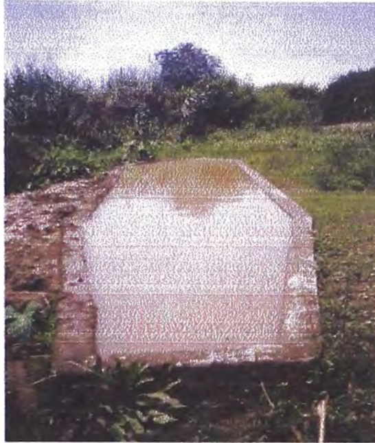
Vista del Desarenador operando por encima del nivel máximo
