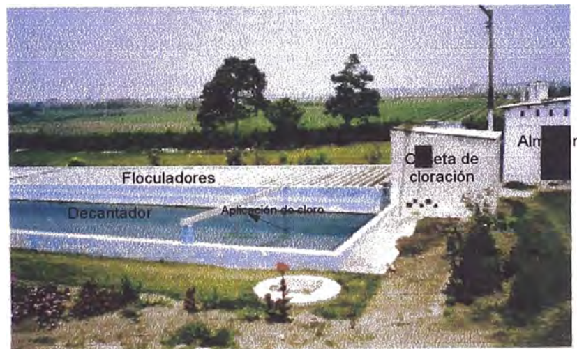
Vista panorámica de la Planta de tratamiento Quepepampa
