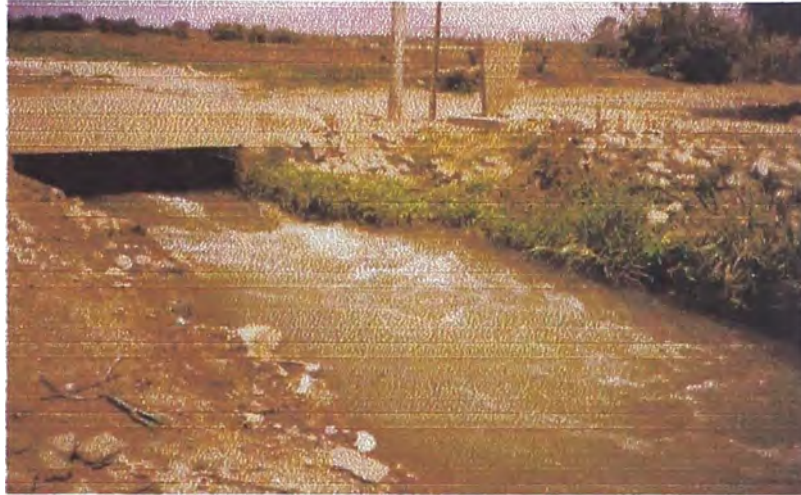
Vista del Canal Chancay Bajo sin revestimiento
