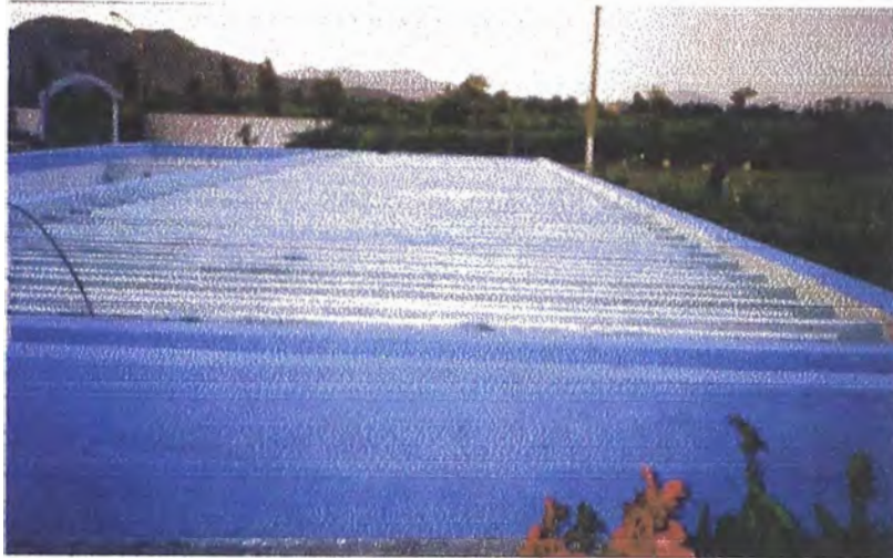
Unidad de Floculación
