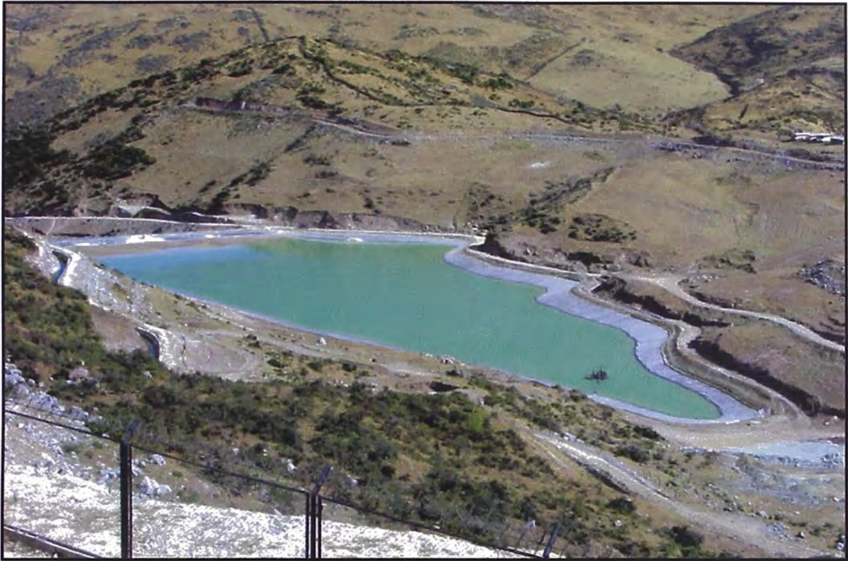
Presa de Relaves
