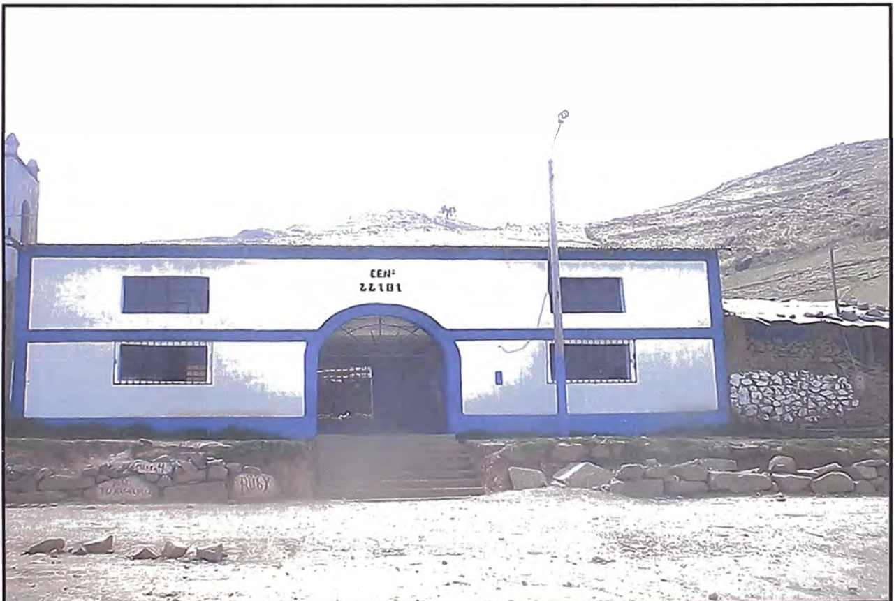
Escuela N° 22181 de la comunidad de Ocobamba remodelada por la empresa
