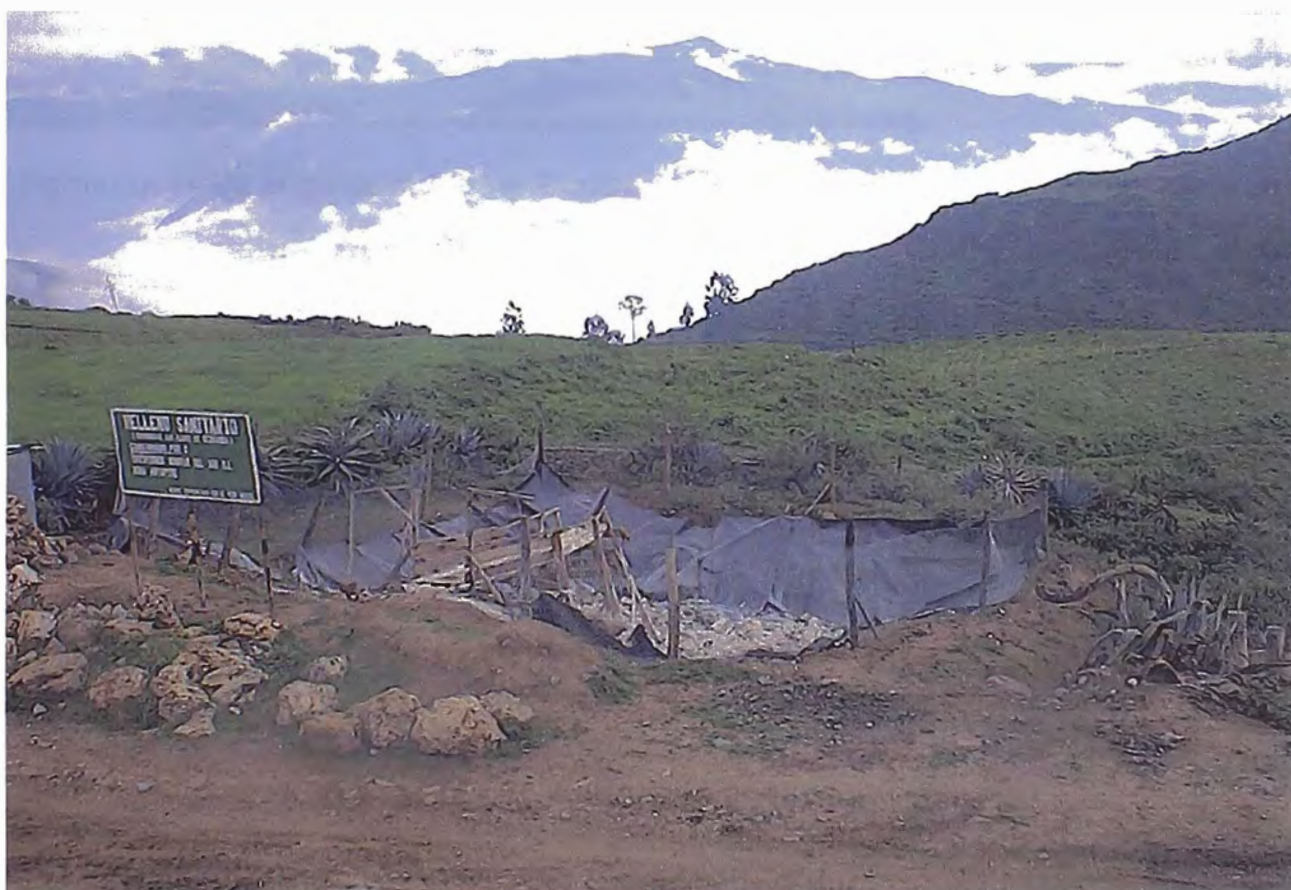
Relleño sanitario construido por la empresa en la comunidad de Ocobamba
