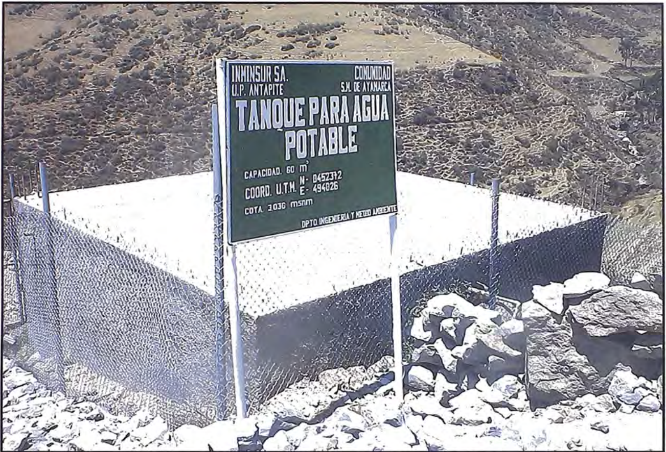
Tanque de agua potable en la comunidad de Ayamarca de 60 m 3 de capacidad construido por la empresa
