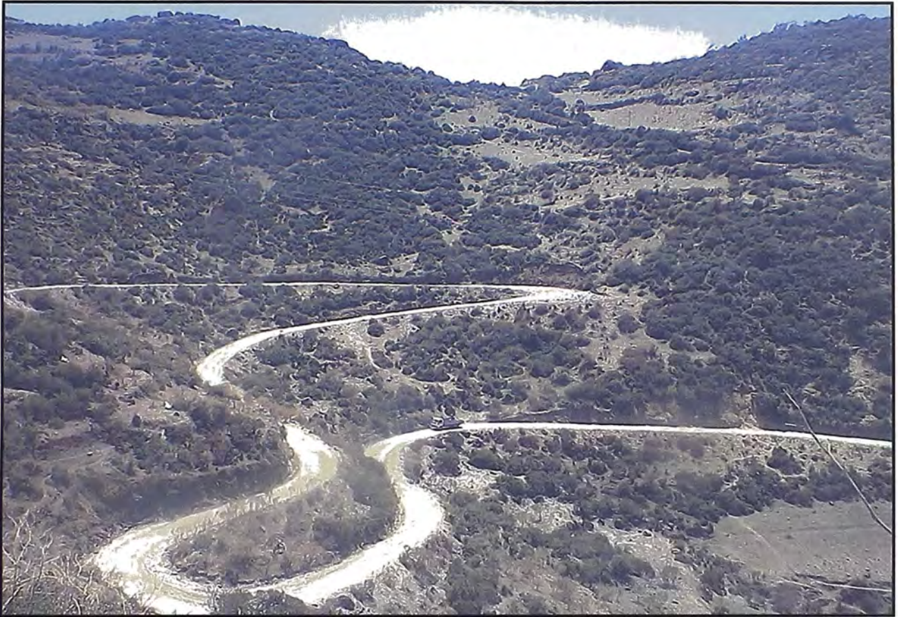
Carretera: Ayamarca - Sune – Ocoyo rehabilitado y construido por la empresa
