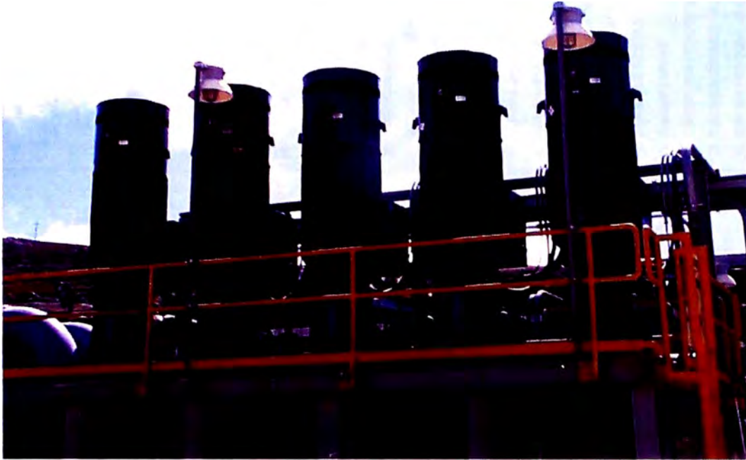
FOTO N° 22: BOMBAS VERTICALES BARREN PLANTA YANACOCCHA NORTE.
