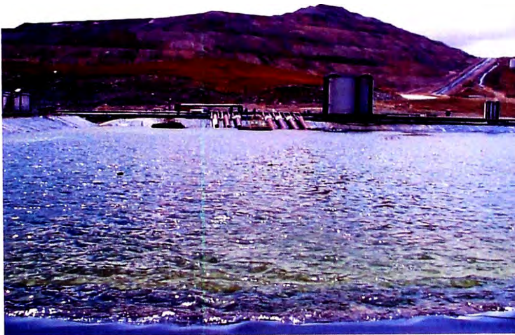
FOTO N° 14: POZA DE OPERACIONES YN
