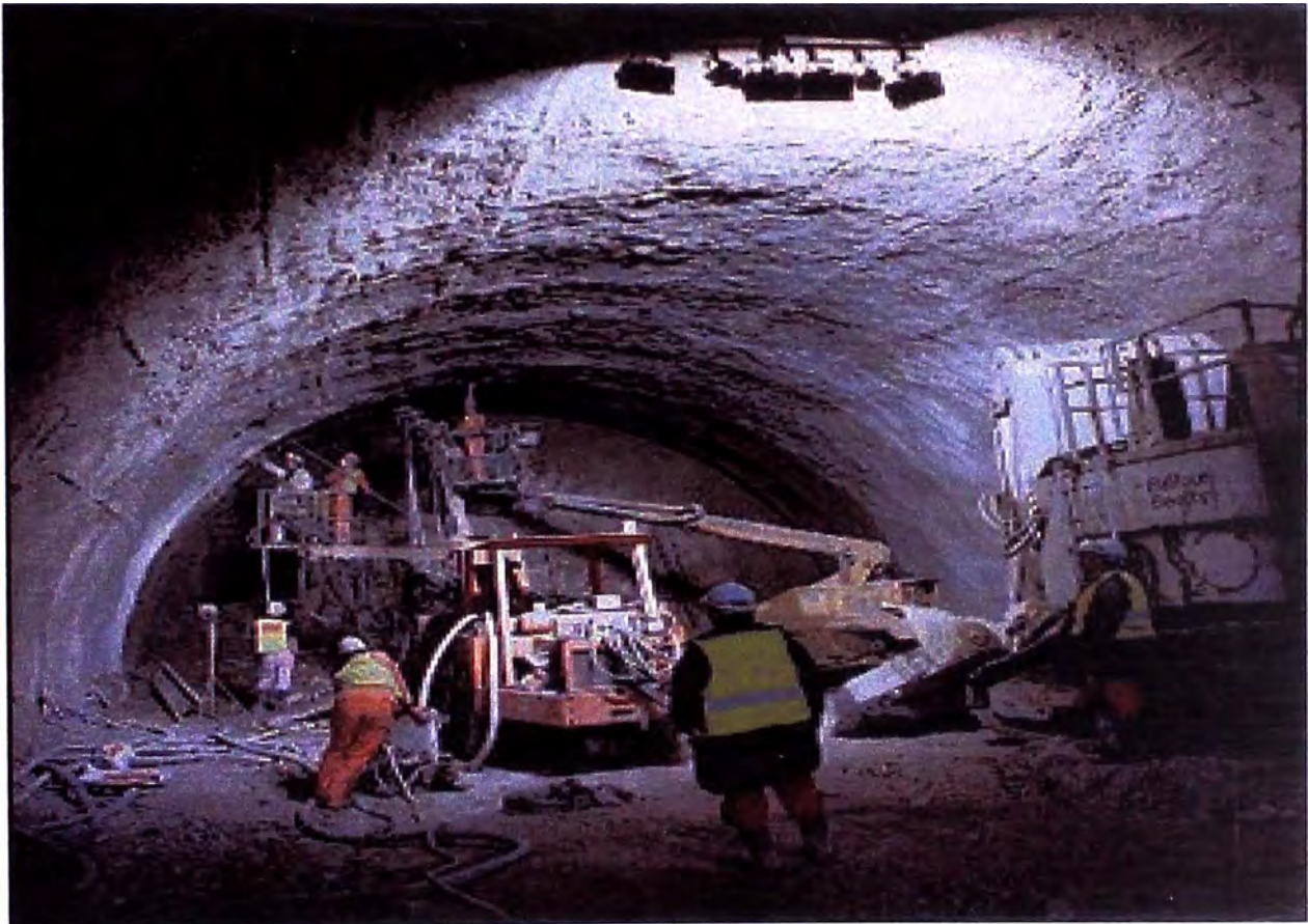
SOSTENIMIENTO CON SHOTCRETE EN AVANCE HORIZONTAL
