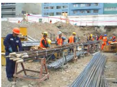
Fig. 2.7. Preparación de anclajes en la obra Casino Atlantic City, Miraflores - Lima. Cortesía Geotécnica S.A.C. Fig. 2.8. Perforación e instalación de anclajes en la obra del Edificio de Aulas y Sótano de la Universidad de Lima, Santiago de Surco - Lima. Cortesía Geotécnica S.A.C.
