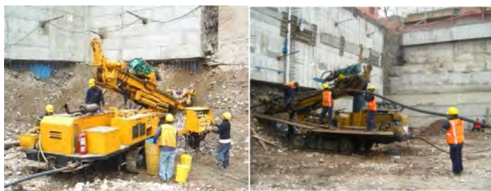
Fig. 2.7. Preparación de anclajes en la obra Casino Atlantic City, Miraflores - Lima. Cortesía Geotécnica S.A.C. Fig. 2.8. Perforación e instalación de anclajes en la obra del Edificio de Aulas y Sótano de la Universidad de Lima, Santiago de Surco - Lima. Cortesía Geotécnica S.A.C.
