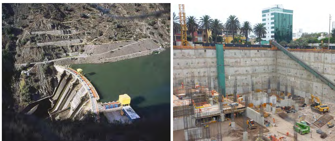
Fig. 3.1. A la izquierda, estabilización de los taludes laterales del vaso de la Presa Tablachaca, Derrumbe N° 05, Huancavelica, Perú - 1982. A la derecha, muros anclados conteniendo los taludes resultantes de la excavación de los sótanos del Edificio de la Clínica Delgado, Miraflores - Lima, Perú - 2011. Cortesía Geotécnica S.A.C.
