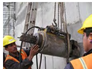
Fig. 2.10. Tensado obra Universidad de Lima. Santiago de Surco - Lima. Cortesía Geotécnica S.A.C.
