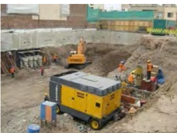
Fig. 2.9. Inyección de anclajes postensados y construcción de los muros estructurales de forma alternada en la obra Javier Prado 200, Magdalena del Mar - Lima. Cortesía Geotécnica S.A.C.
