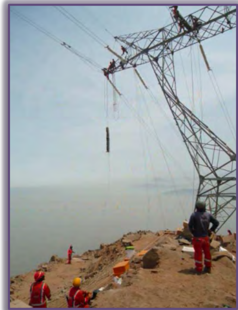
Foto 14: Vestido de torres- colocación de aisladores
