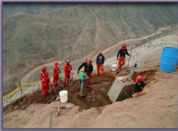
Foto 9: Compactación de la cimentación de la torre
