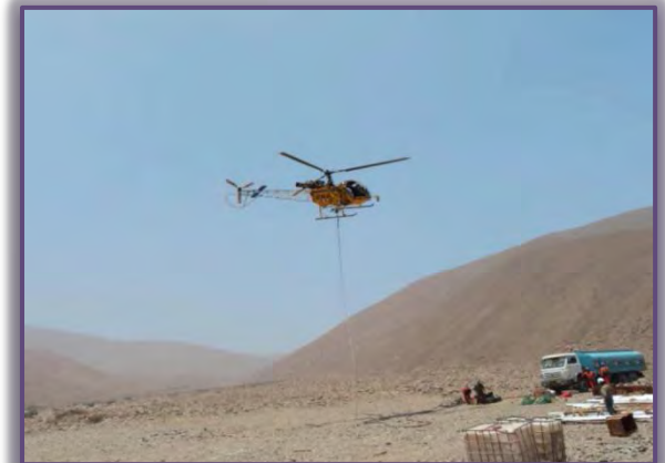
Foto 12: Transporte de estructuras metálicas por helicóptero
