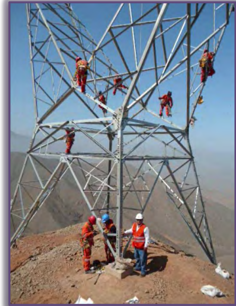
Foto 18: Revisión de torre previa a la Entrega Final.
