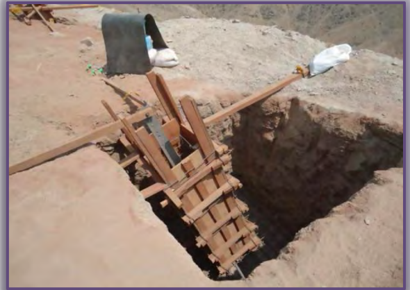
Foto 6: Encofrado del pedestal de la torres
