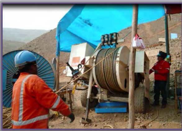
Foto 15: Tendido de conductor, cable de guarda y fibra óptica.
