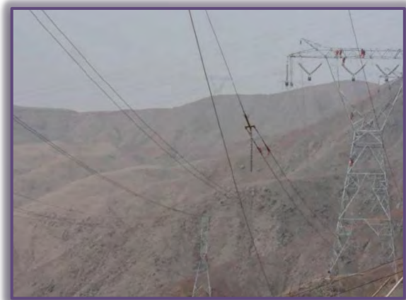
Foto 16: Flechado de conductor, cable de guarda y fibra óptica
