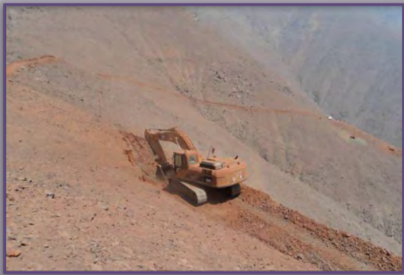
Foto 1: Habilitación de caminos de acceso
