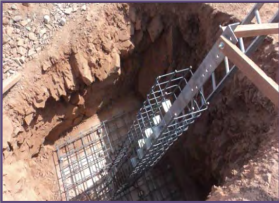
Foto 5: Habilitación de acero en zapata de cimentación
