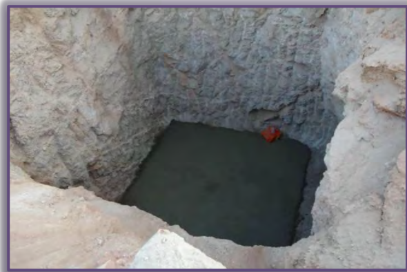
Foto 3: Solado de Concreto
