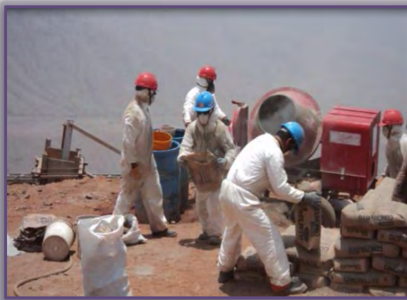
Foto 7: Preparación del concreto pre-listo
