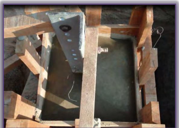
Foto 8: Vaceado del concreto a la cimentación de la torre
