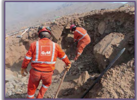
Foto 2: Excavación de cimentación de la torre
