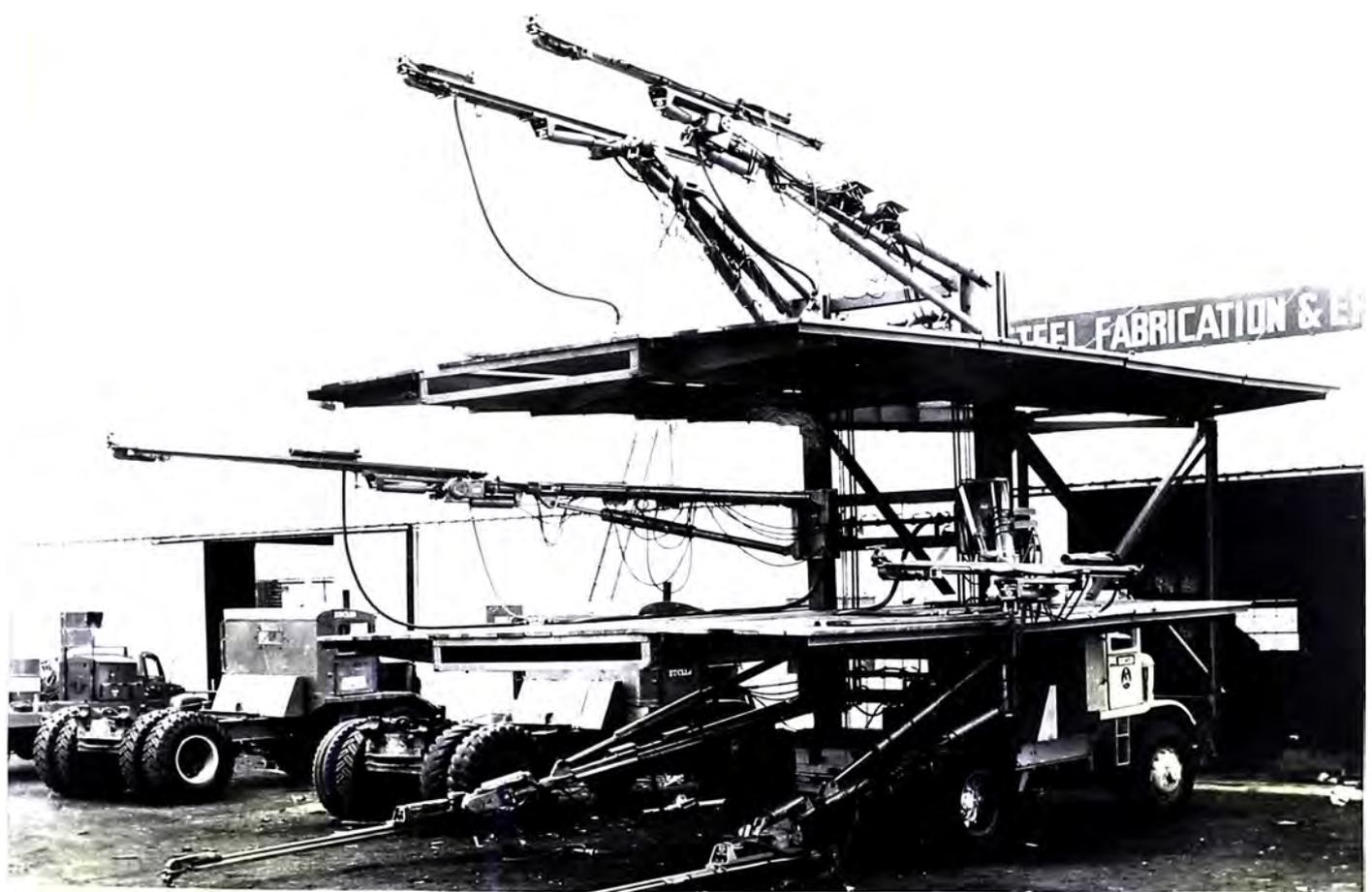
Figura No. 1 Fotografía de un Jumbo para perforar Túneles
