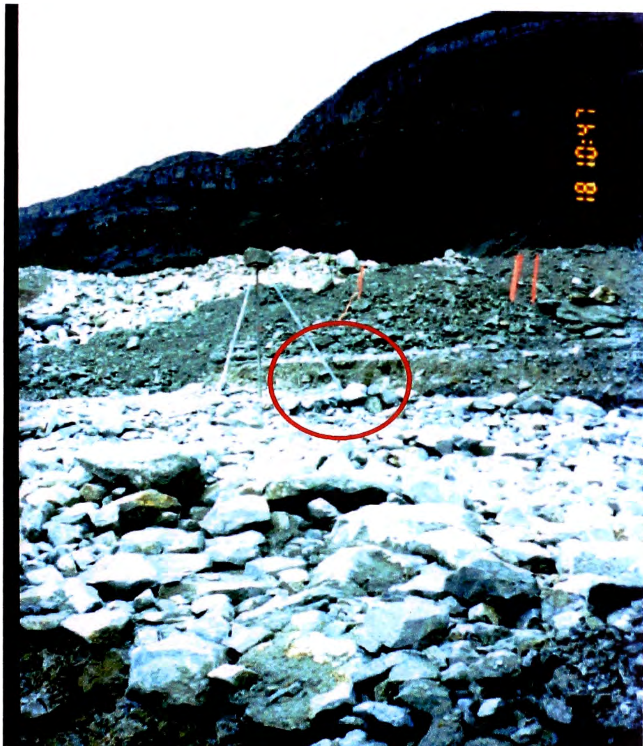
FOTO N °14: EN ESTA VISTA SE PUEDE OBSERVAR UN TRÍPODE INTERMEDIO QUE SE ENCUENTRA CERCA DE UN AGRIETAMIENTO EN LA PLATAFORMA.
