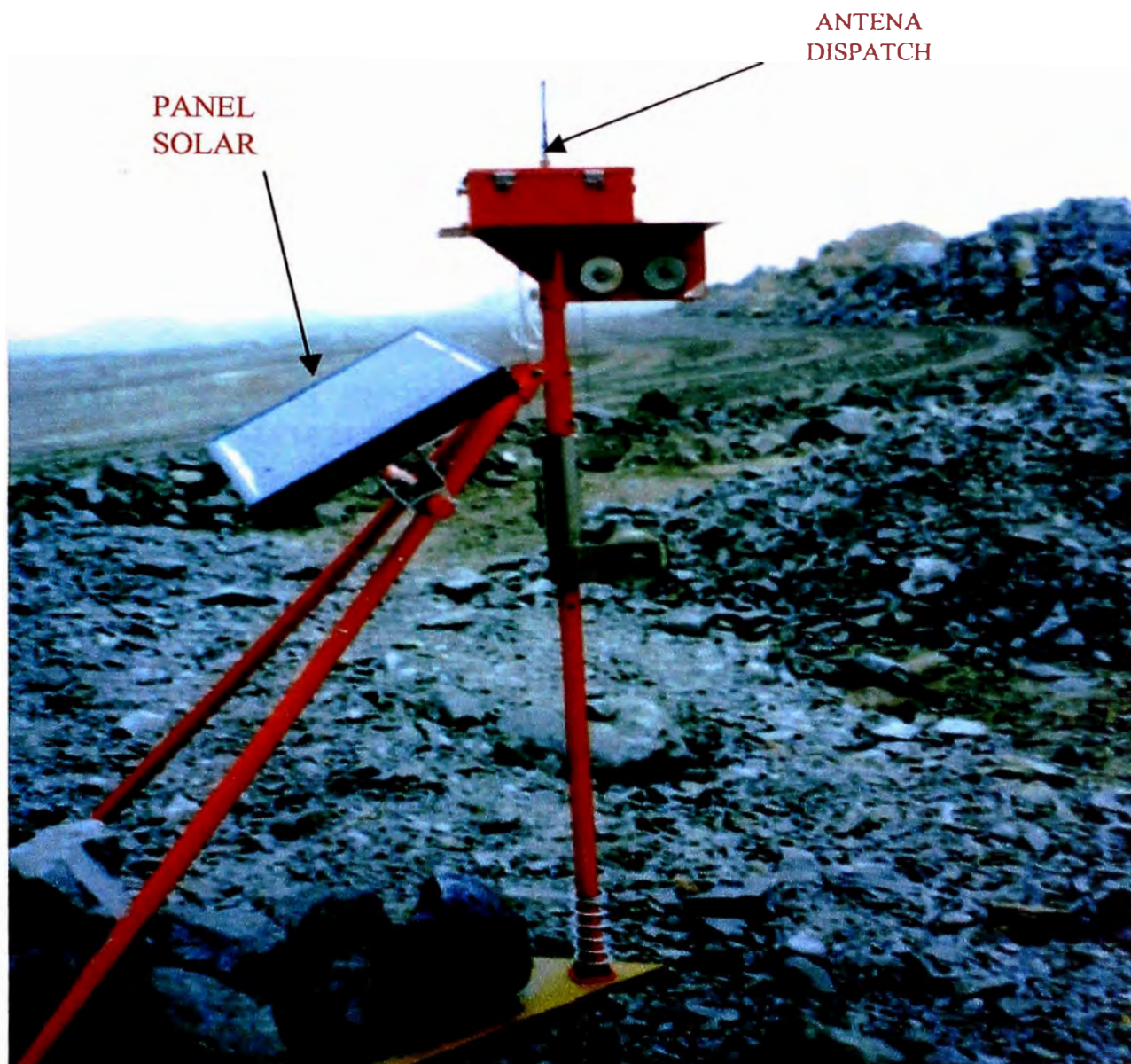
FOTO N °7: VISTA COMPLETA DE UN EXTENSÓMETRO ELECTRÓNICO, OBSERVANDO EL PANEL SOLAR, EL MECANISMO QUE RECIBE Y EMITE LAS SEÑALES A LA OFICINA DE GEOTECNIA
