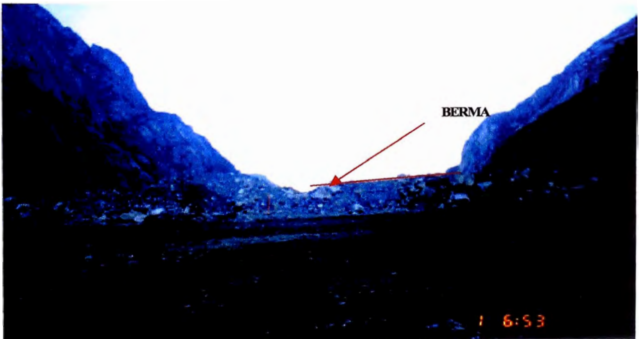
FOTO N °9: EN ESTA VISTA SE PUEDE OBSERVAR LAS BERMAS QUE SE UTILIZAN PARA LA DESCARGA DE MATERIAL.
