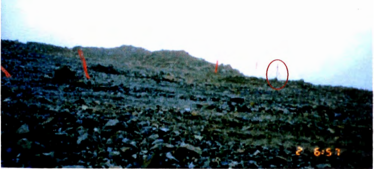
FOTO N °16: EN ESTA VISTA SE PUEDE OBSERVAR EL PUNTO DE REFERENCIA LOCALIZADO EN LA CRESTA DEL TALUD Y EL CABLE TENSADO.
