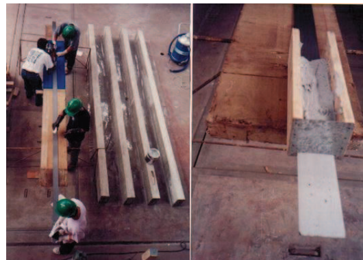
Foto 1.2 Colocación de Adhesivo en la lámina de fibra de carbono.
