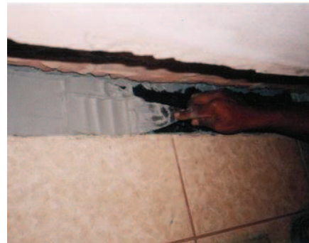
Foto 1.6 Colocación de una capa de acabado sobre platina para protección.
