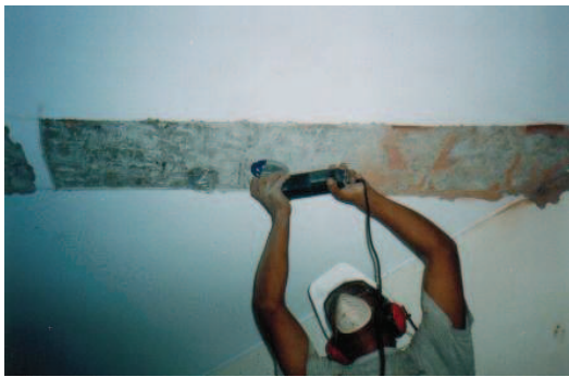
Foto 1.3 Control de Humedad en la superficie de concreto.
