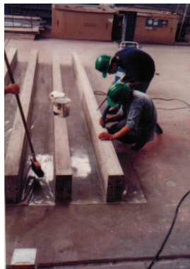
Foto 1.1 Preparación de la superficie de concreto
