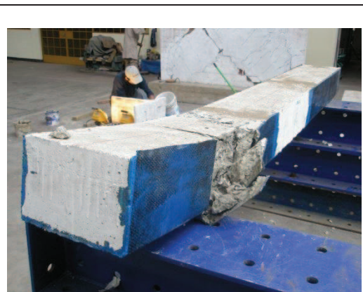
Foto 4.48 Vista de la falla de la viga 3C
