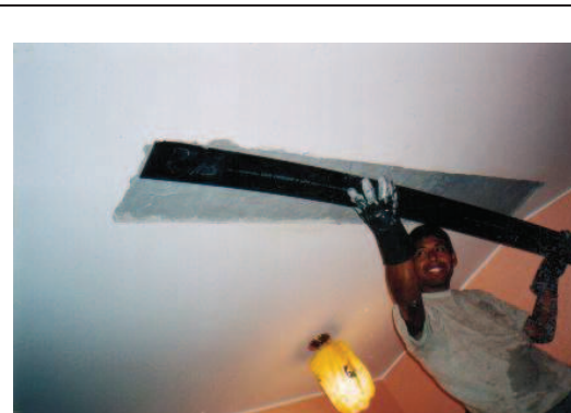
Foto 1.5 Colocación en obra de la platina de fibra de carbono.
