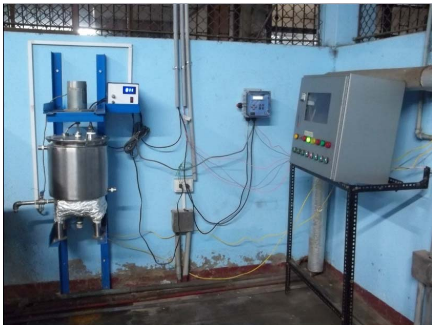
Figura 9. Reactor multipropósito a nivel banco. En este equipo automatizado se realizaron diversas pruebas de pretratamiento químico, hidrólisis enzimática y fermentación alcohólica, sensando y controlando las principales variables de operación (temperatura y pH) durante cada una de las experiencias.
