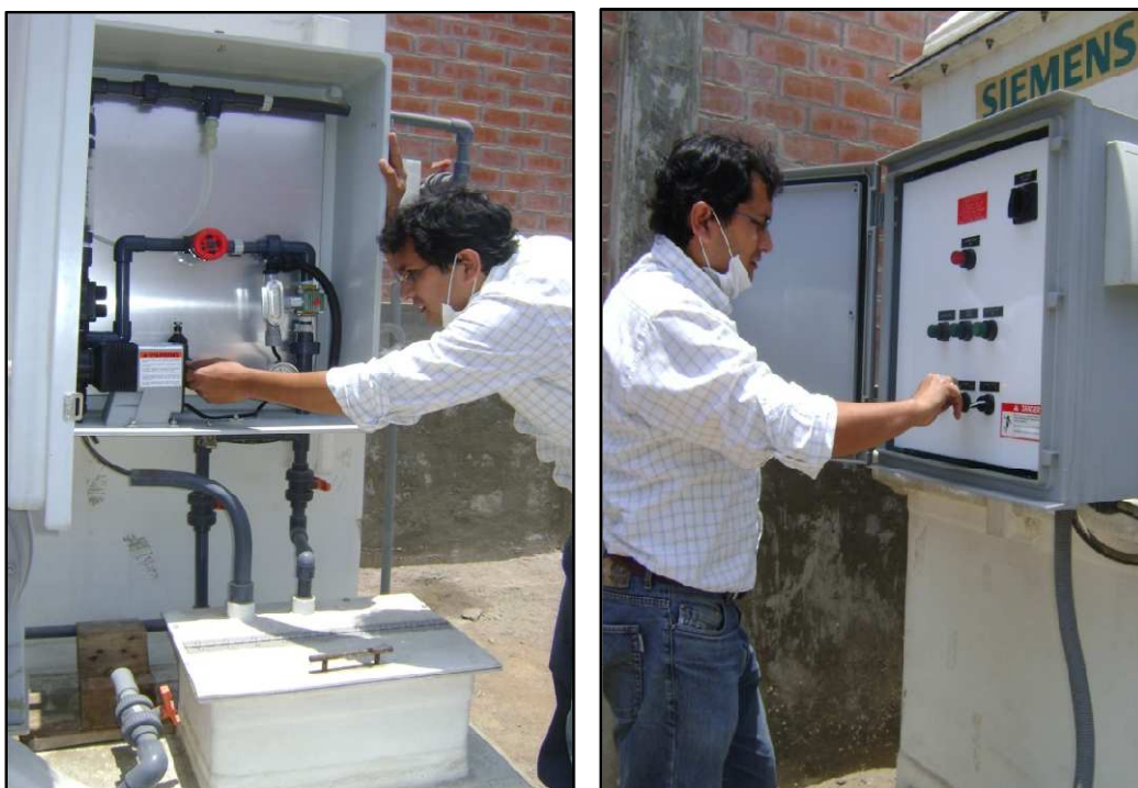
Figura 4.17: Ajuste de la dosis en la bomba dosificadora de nutrientes.
