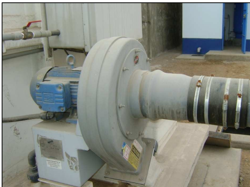
Figura 4.8: Extractor centrífugo fabricado en fibra de vidrio
