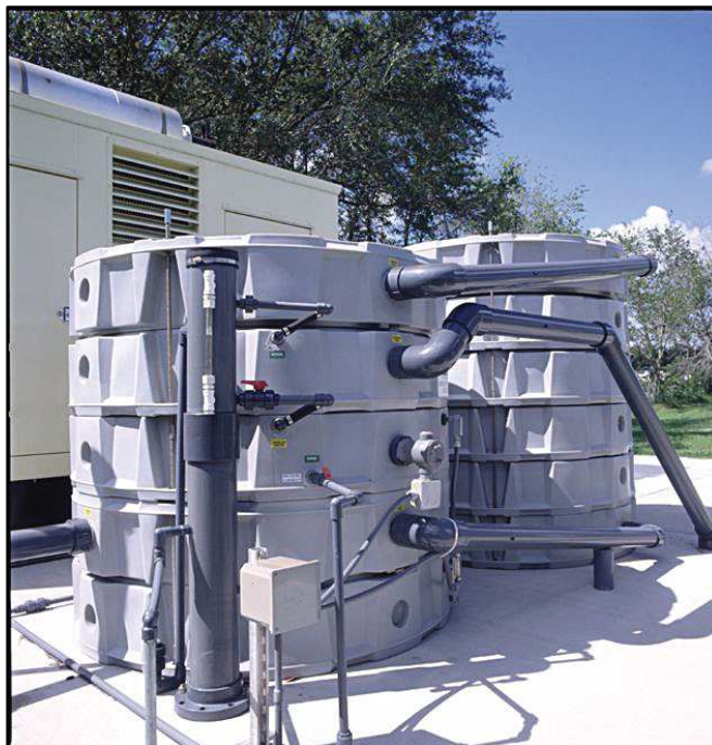
Figura 3.21: Sistema de humidificación del flujo de aire en un biofiltro orgánico (Biorem, 2000)
