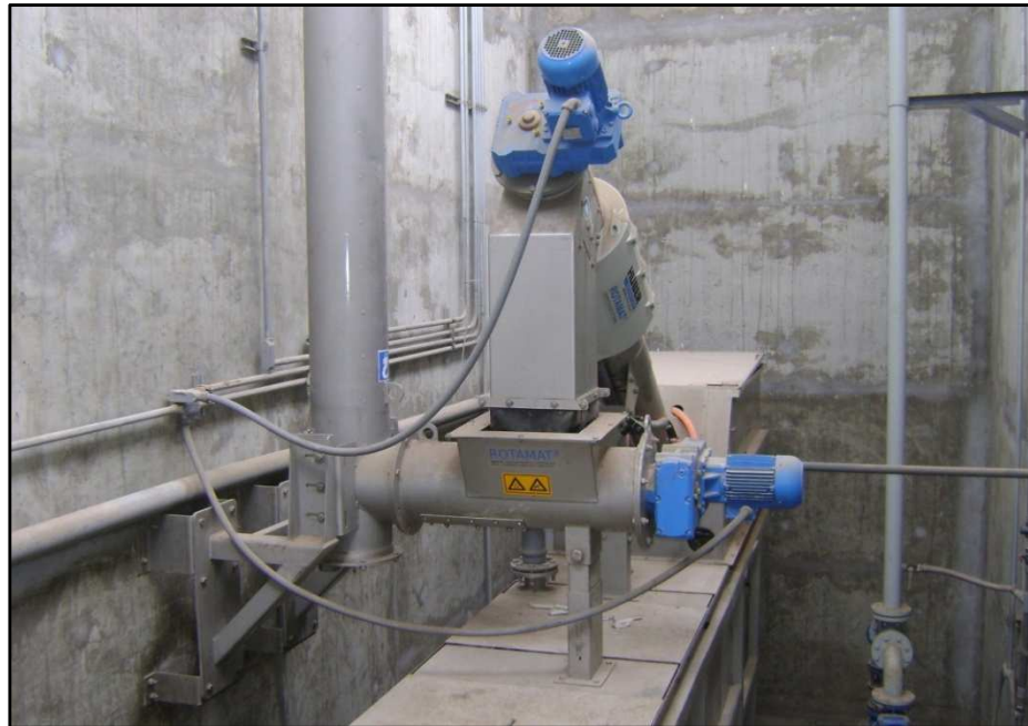
Figura 4.3: Tamiz fino y compactador de residuos sólidos
