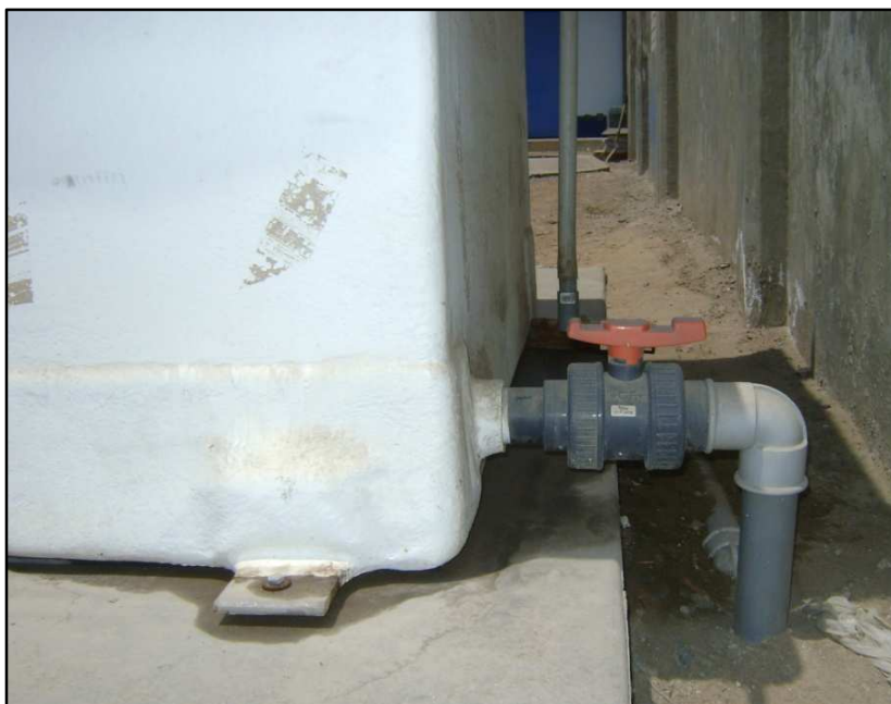
Figura 4.12: Válvula de bola para el drenaje de lixiviado
