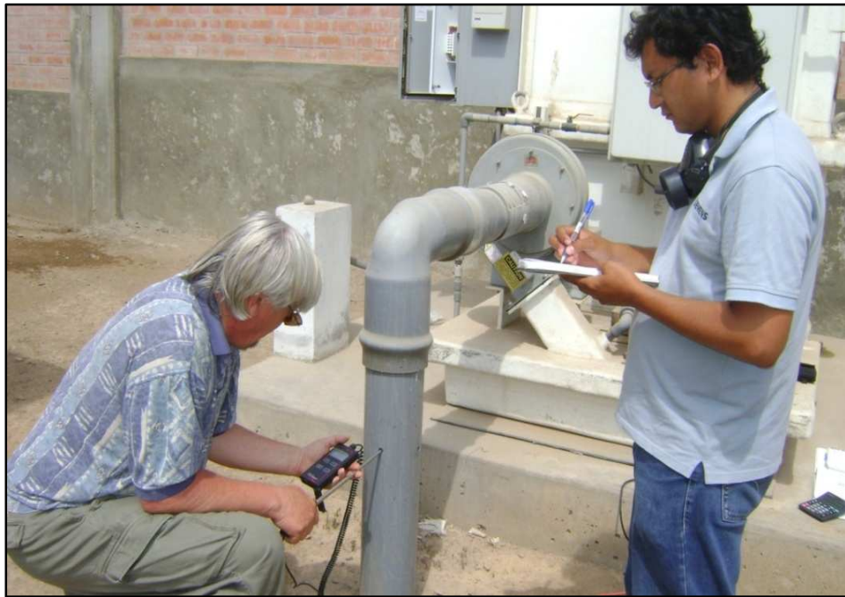
Figura 4.21: Medición de la velocidad en el ducto utilizando un anemómetro digital.
