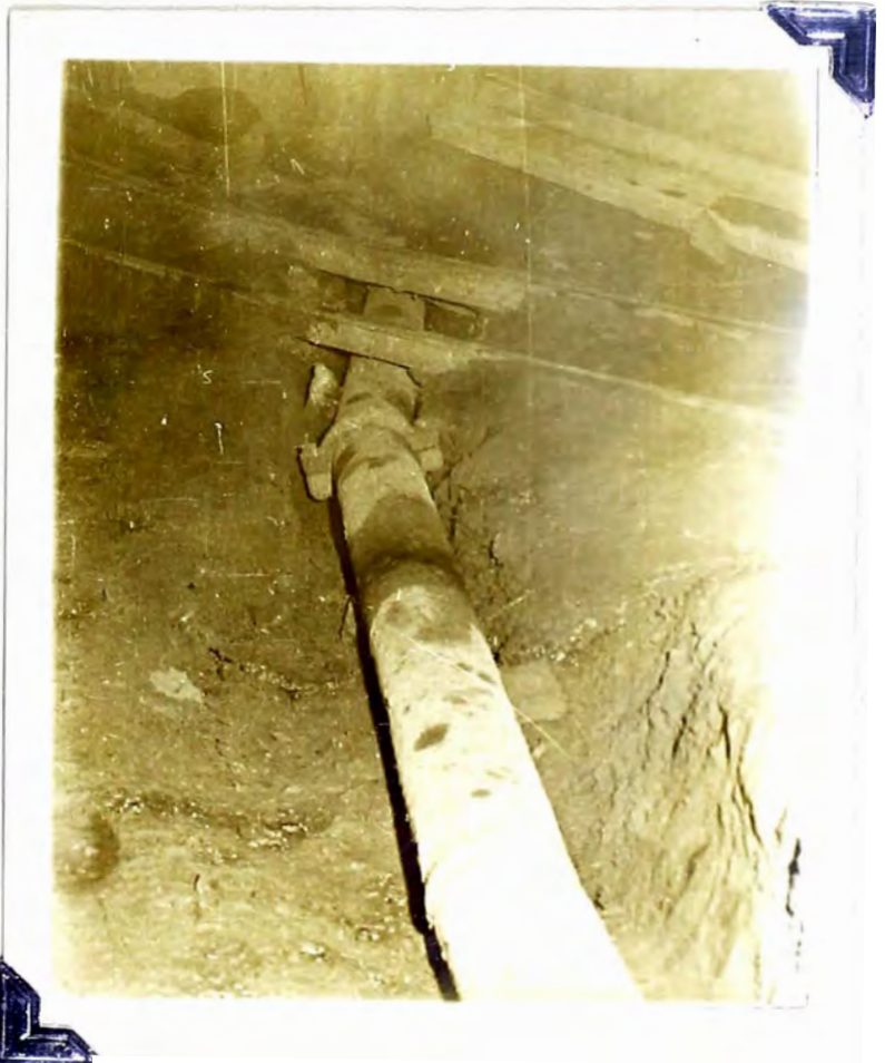
Tubería troncal debajo de la línea decauville
