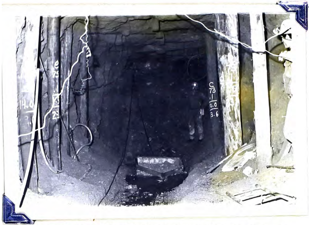
Tajeo mostrando el sostenimiento retrazado
