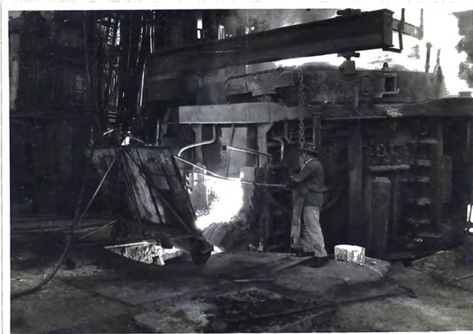
Fig. 5 : Lanza de oxígeno en el Horno Eléctrico.
