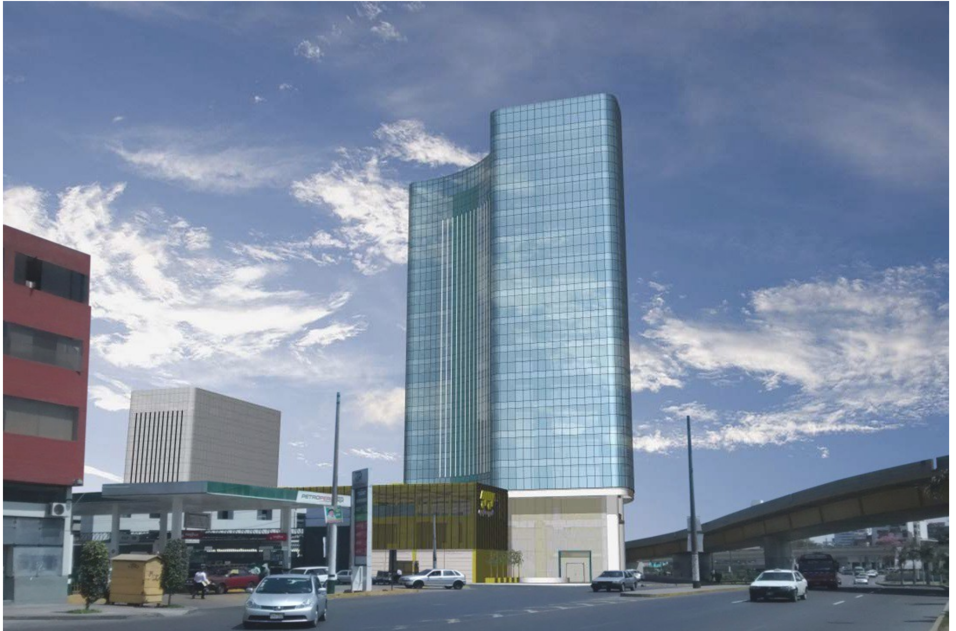
VISTA EXTERIOR DESDE LA AVENIDA MÉXICO
