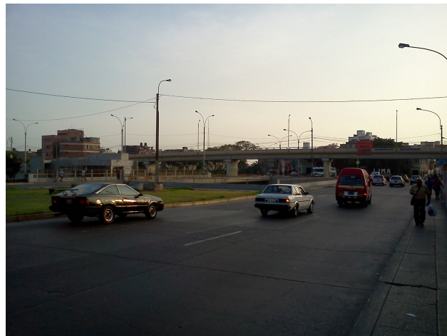
Imagen 3 – Tránsito sobre el Puente México (Fuente: Propia)
