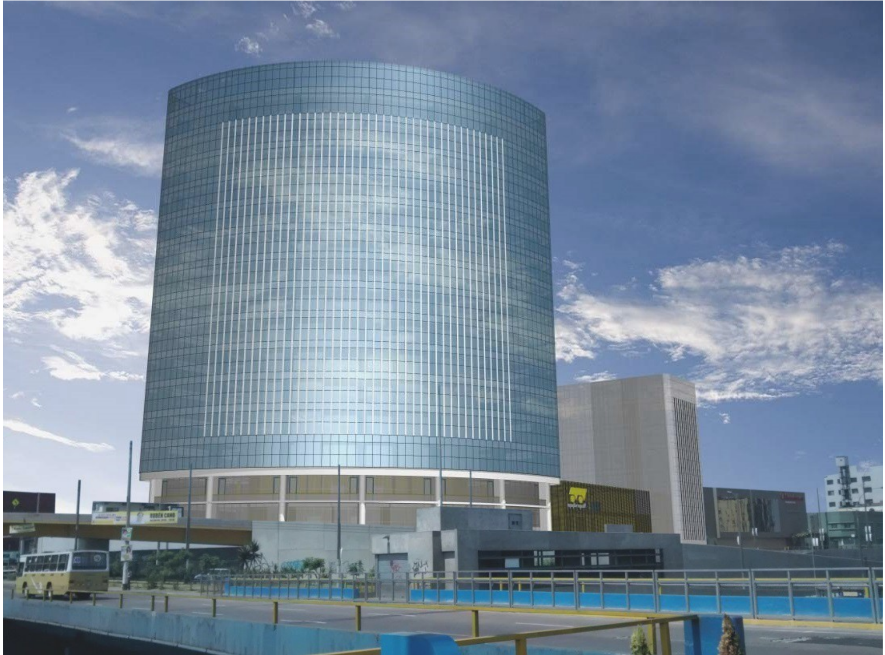
VISTA EXTERIOR DESDE EL PUENTE MÉXICO
