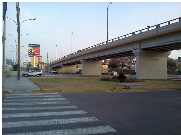
Imagen 4 – Intercambio vial (Fuente: Propia)
