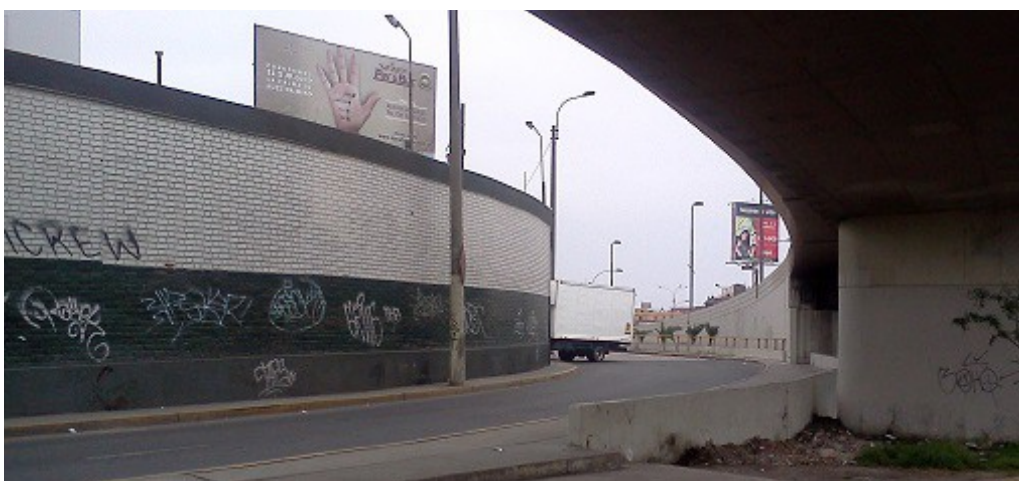
Imagen 14 – Vista de la esquina en entre México y Paseo de la República (Fuente: Propia)
