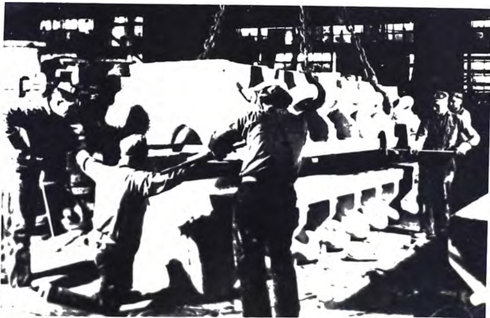
Fotografía N°4 Ensamblado del Molde.
