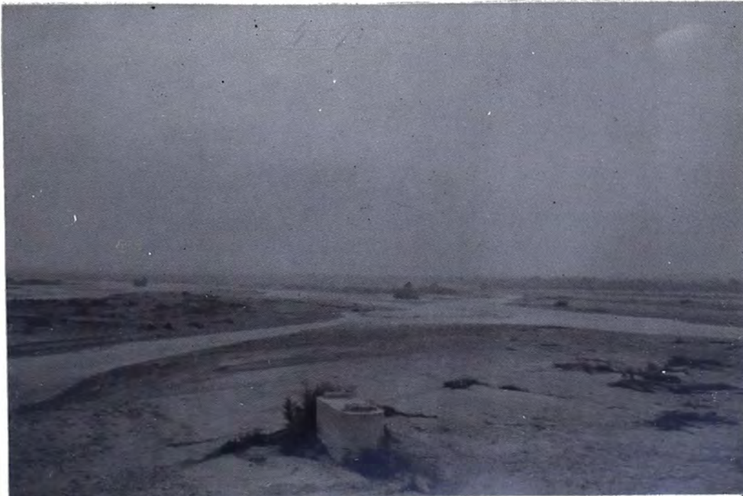
Foto No. 4 Río Santa Margen Izquierda-Aguas Arriba
