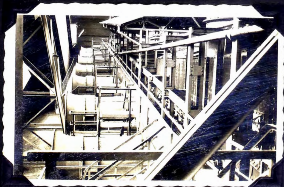
Fig 42.- Los ventiladores de enfriado (Chaleroi-Bélgica)
