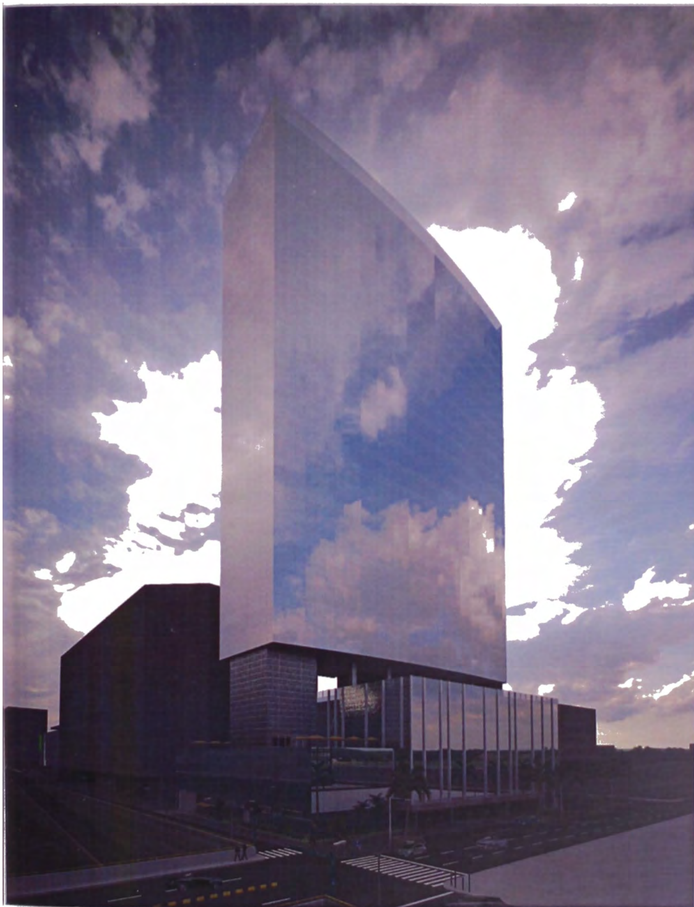
HOTEL 5 ESTRELLAS. Vista en el cruce de la Av. Paseo de la República y Andrés Reyes
