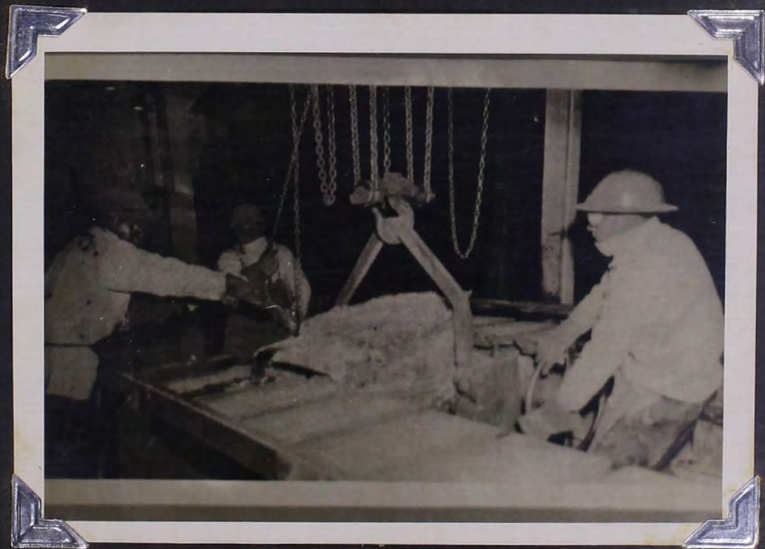
Operación de Colada Manual.
