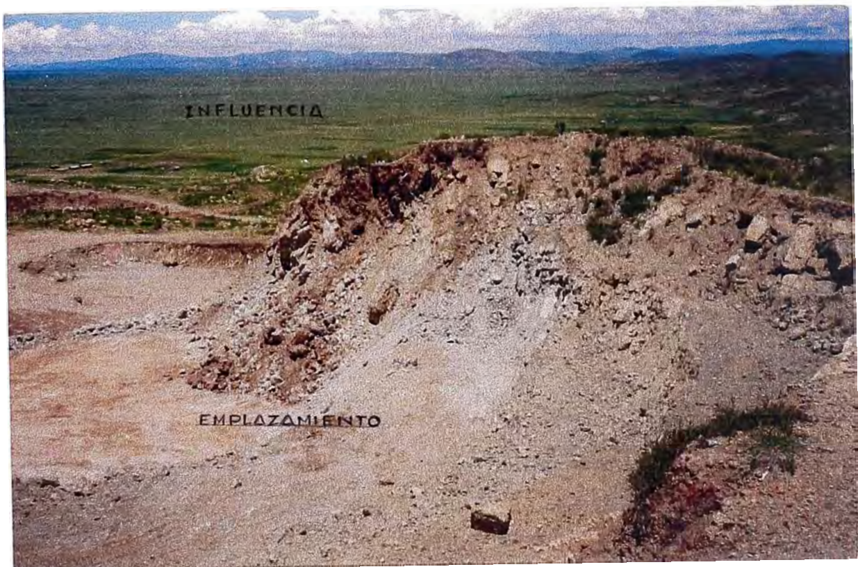
FOTO N° 6: Area de Emplazamiento (Canteras) y Areas de Influencia; ambos con presencia de Vegetación.
