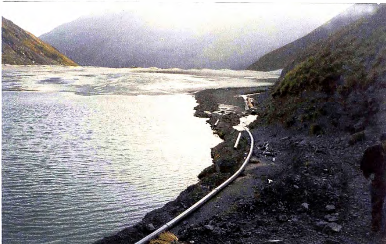
Fotografía N° 18 - Vista General del Vertedero
