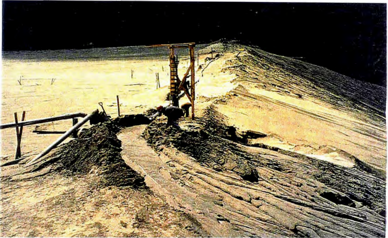
Fotografía N° 24 A - No existe técnica alguna de clasificación y no tiene borde libre
