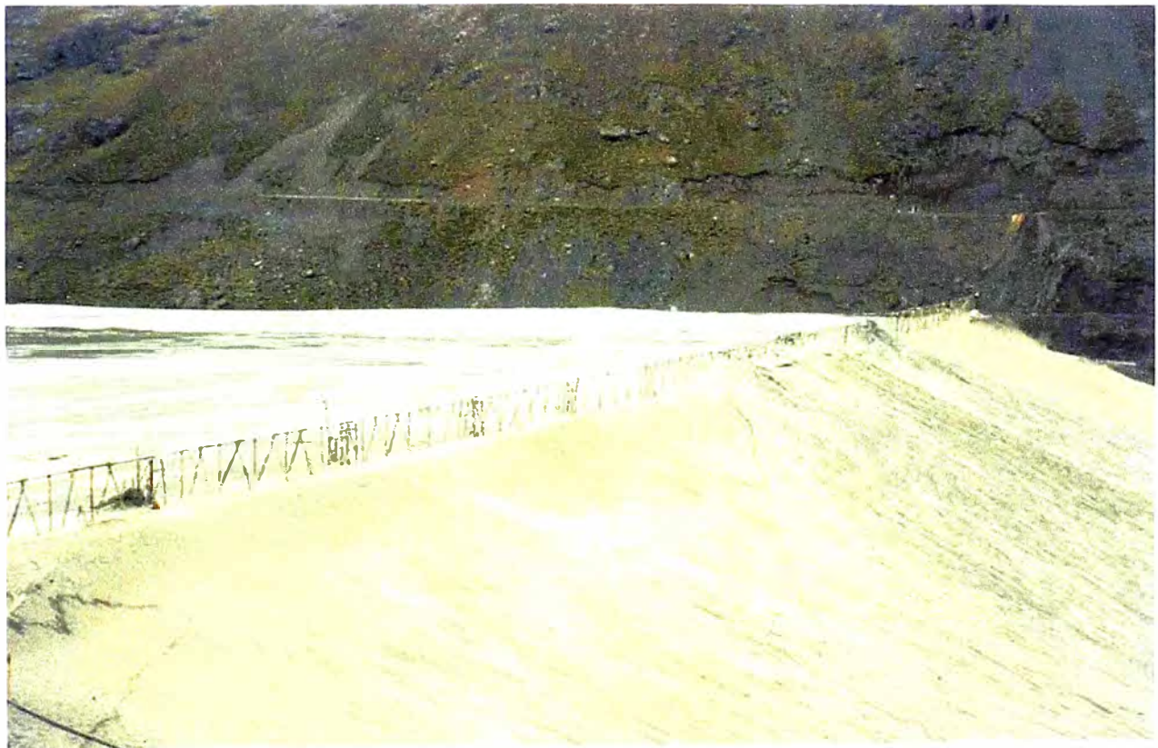
Fotografía N° 25 B - Vista general del nuevo sistema de clasificación y borde libre
