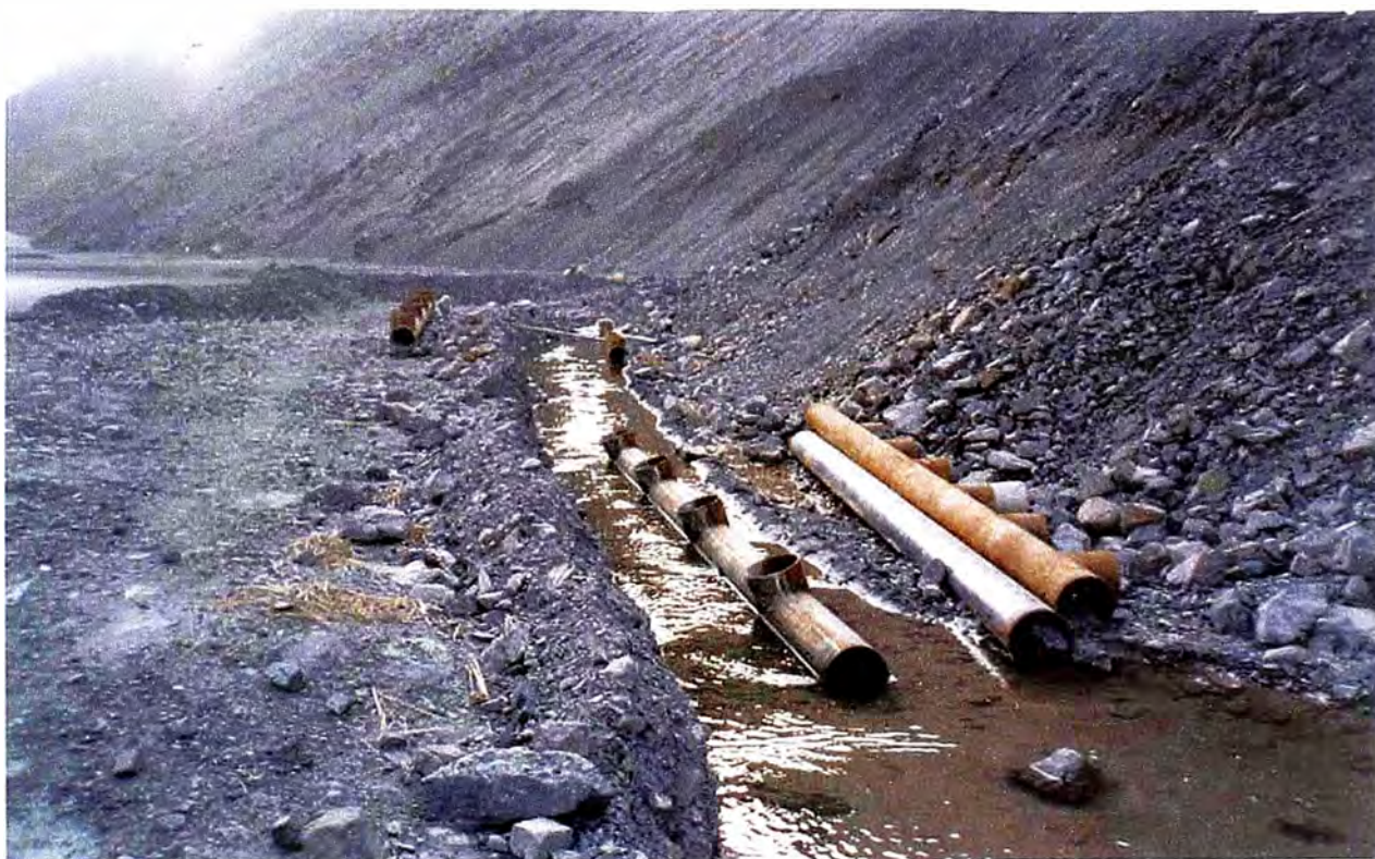
Fotografía N° 19 - Canal de conducción en el vertedero
