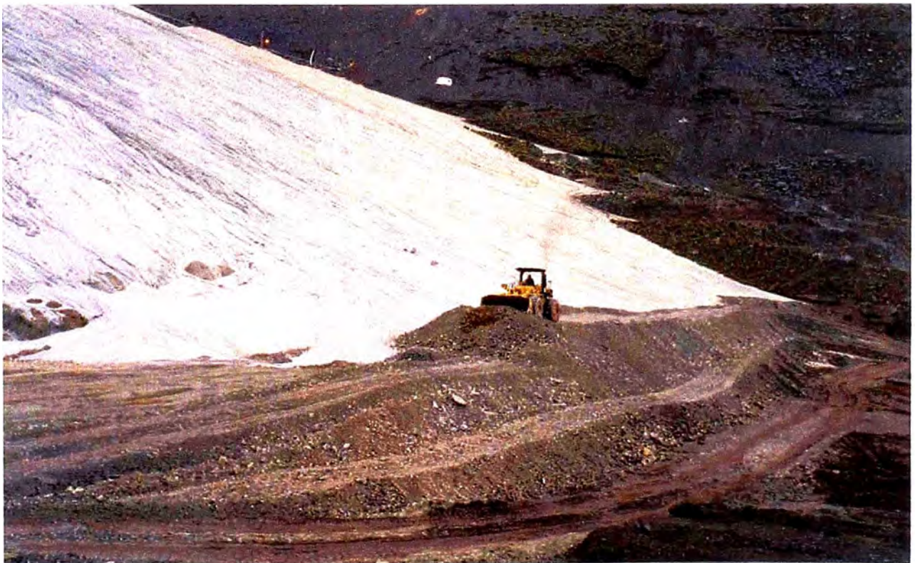
Fotografía N° 29 B - Nivelado y compactado de la banqueta con cargador frontal.
