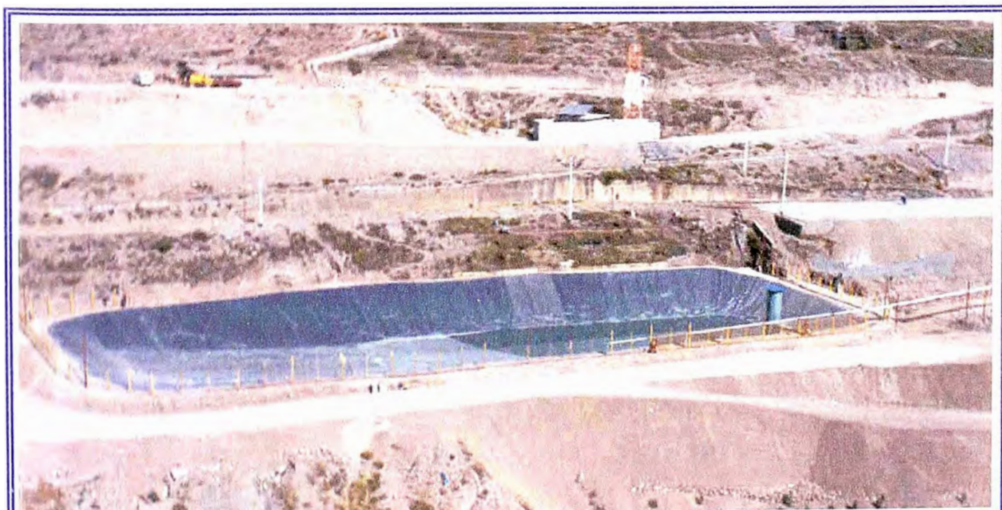
Fotografía N° 6 – Depósito Auxiliar de Relaves, En Operación Actual
