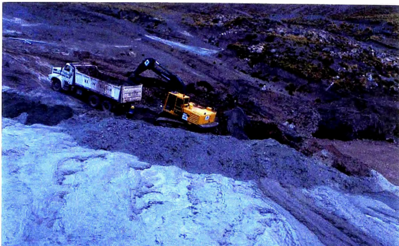
Fotografía N° 26 A - Retiro de la turba orgánica
