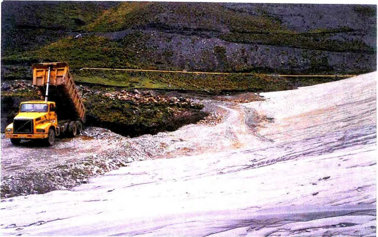
Fotografía N° 29 A - Descarga del desmote minero en la banqueta y el extremo inferior del dique de la presa.
