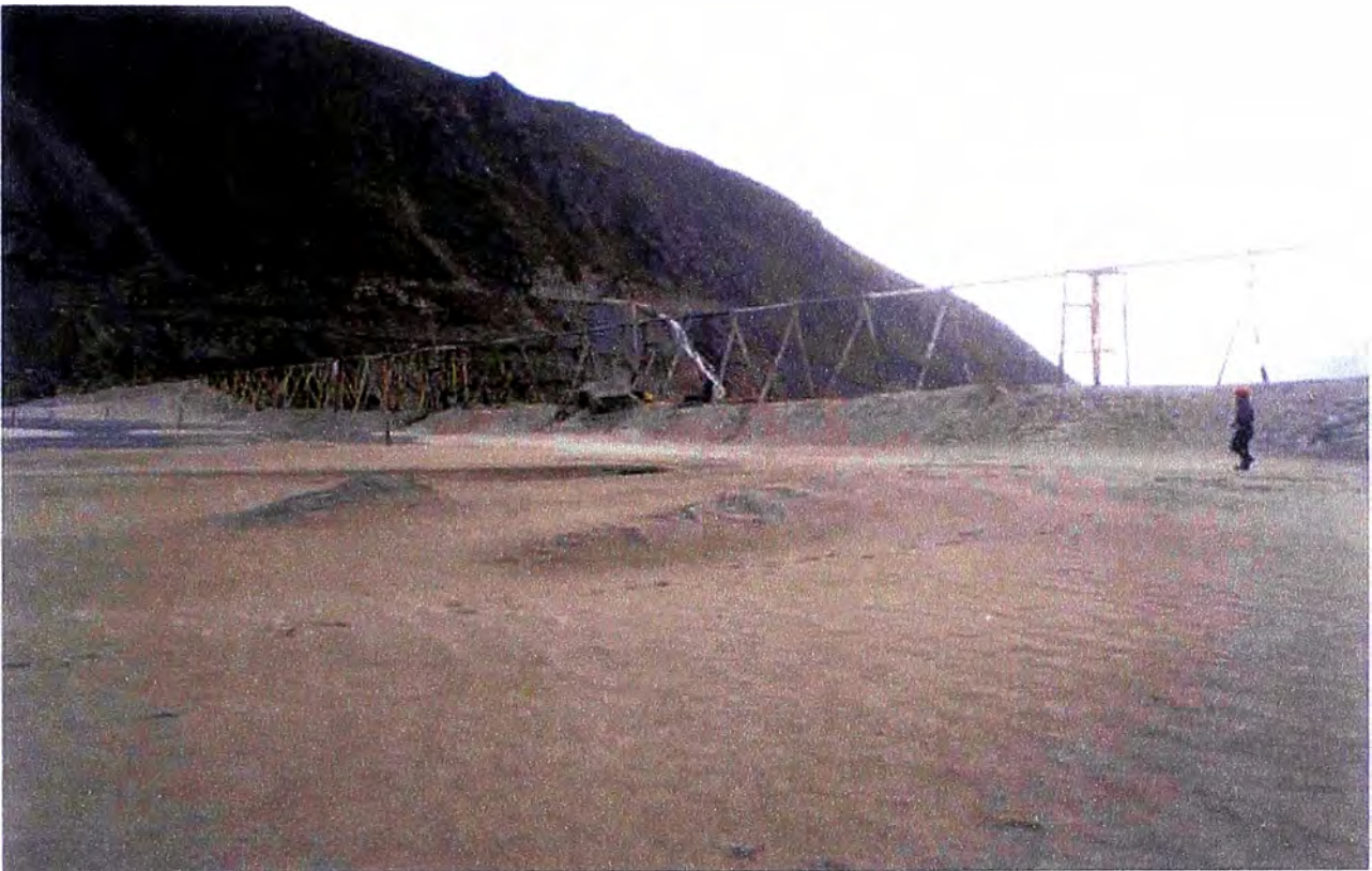
Fotografía N° 25 A - Observase la nueva línea de conducción y el nuevo borde libre
