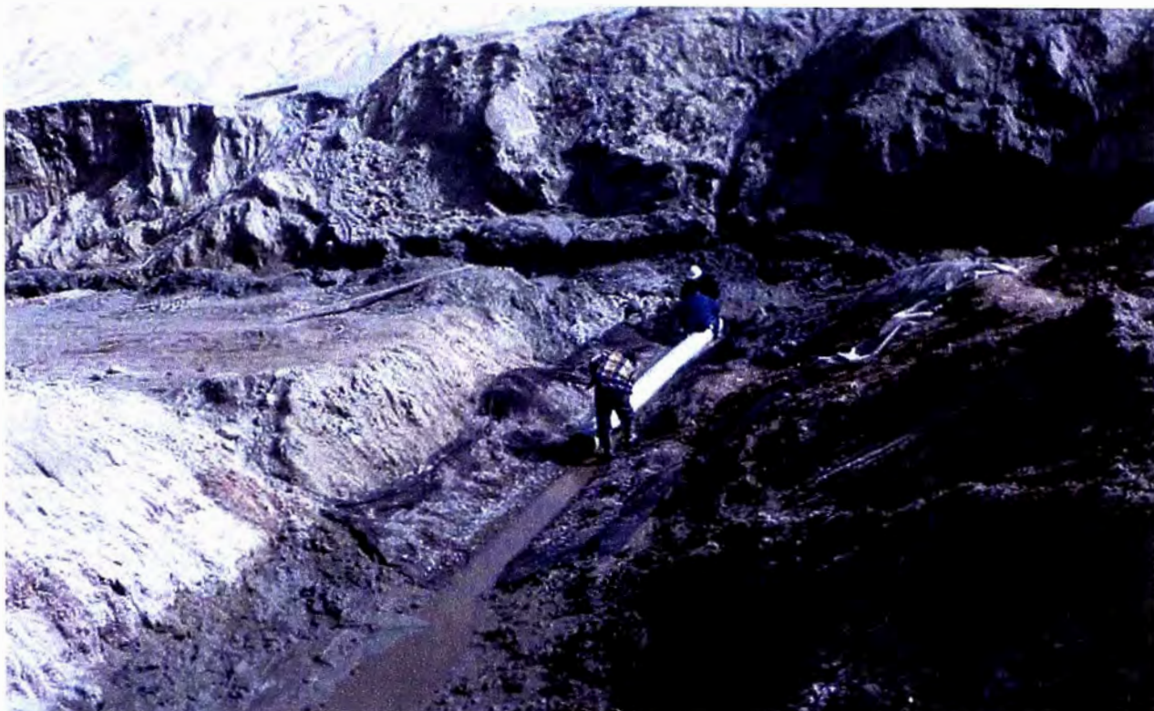
Fotografía N° 27 A - Instalación de un dren interceptor en la base del dique
