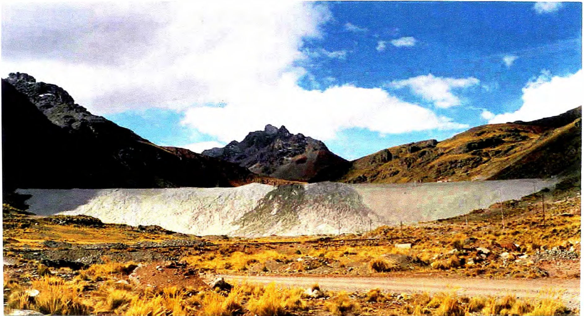
Fotografía N° 2 Paraje de Chinchán - Presa de Relaves Chinchán (1,999)
