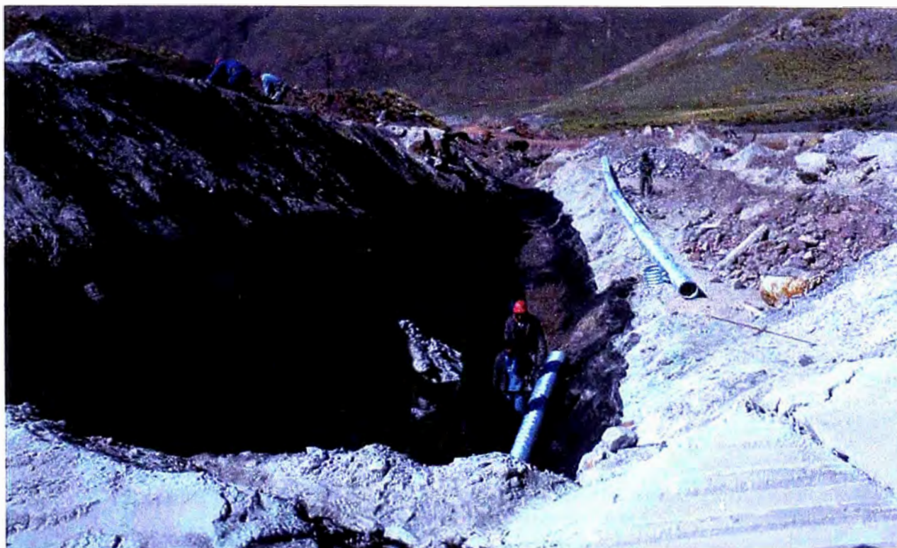
Fotografía N° 27 B - Prolongación de un dren colector en la base del dique
