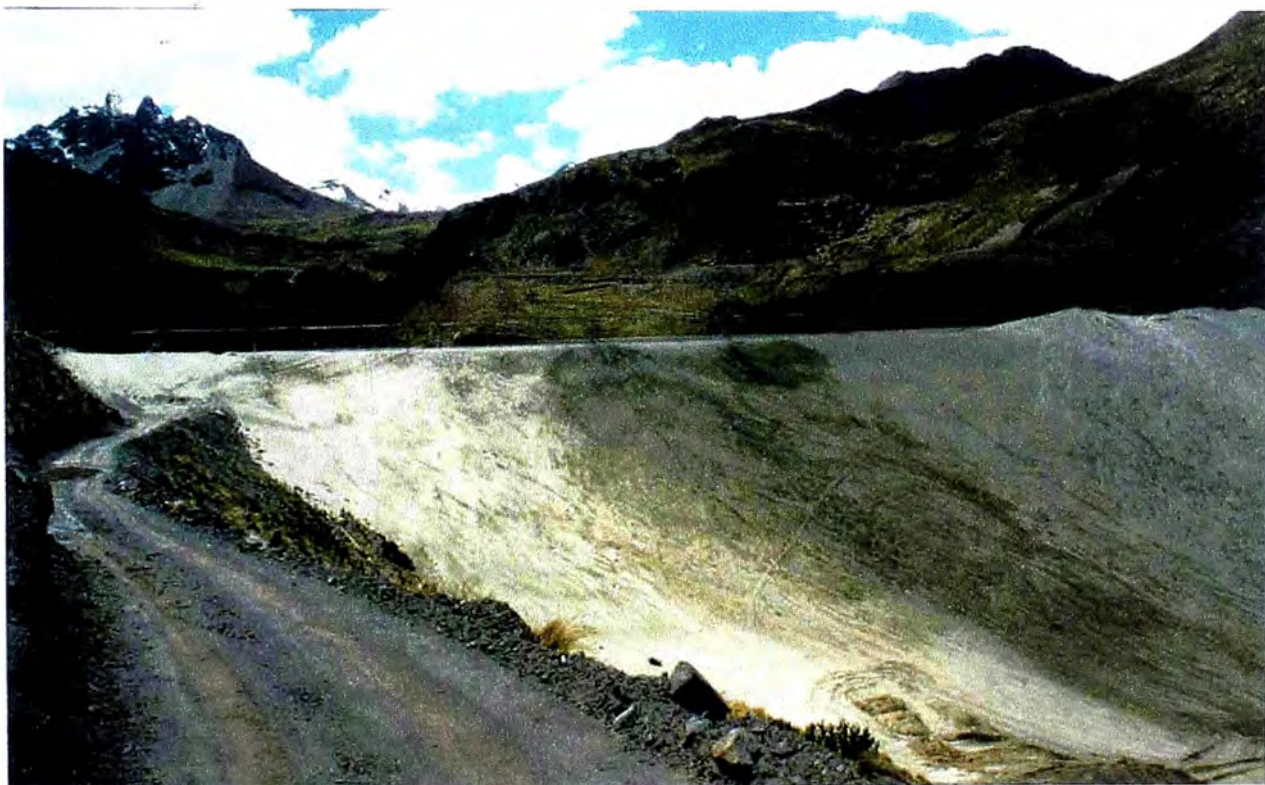
Fotografía N° 23 B - Vista general de humedecimiento por aspersión
