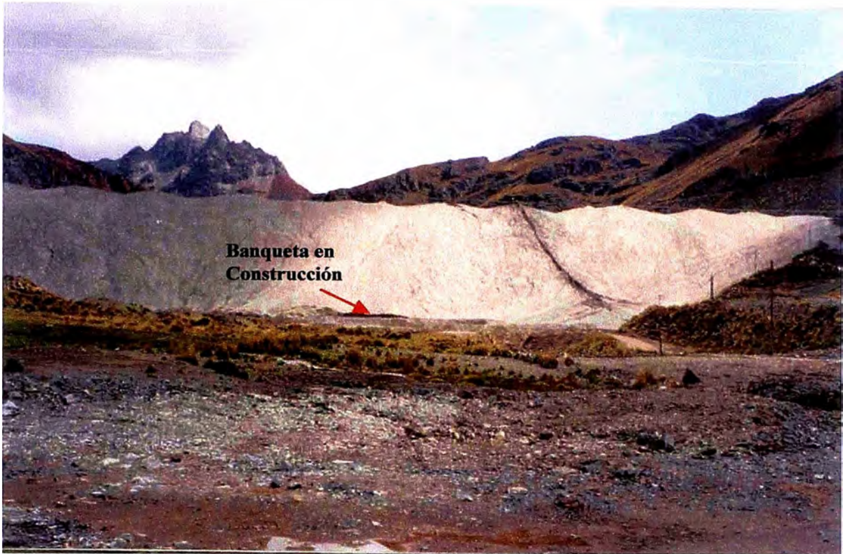
Fotografía N° 28 A - Vista frontal de la Banqueta de refuerzo en construcción.
