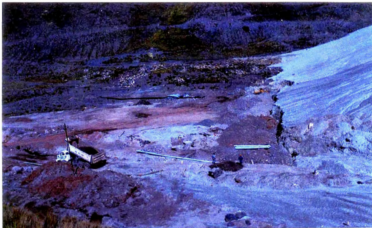
Fotografía N° 26 B - Reemplazo con material filtro resistente
