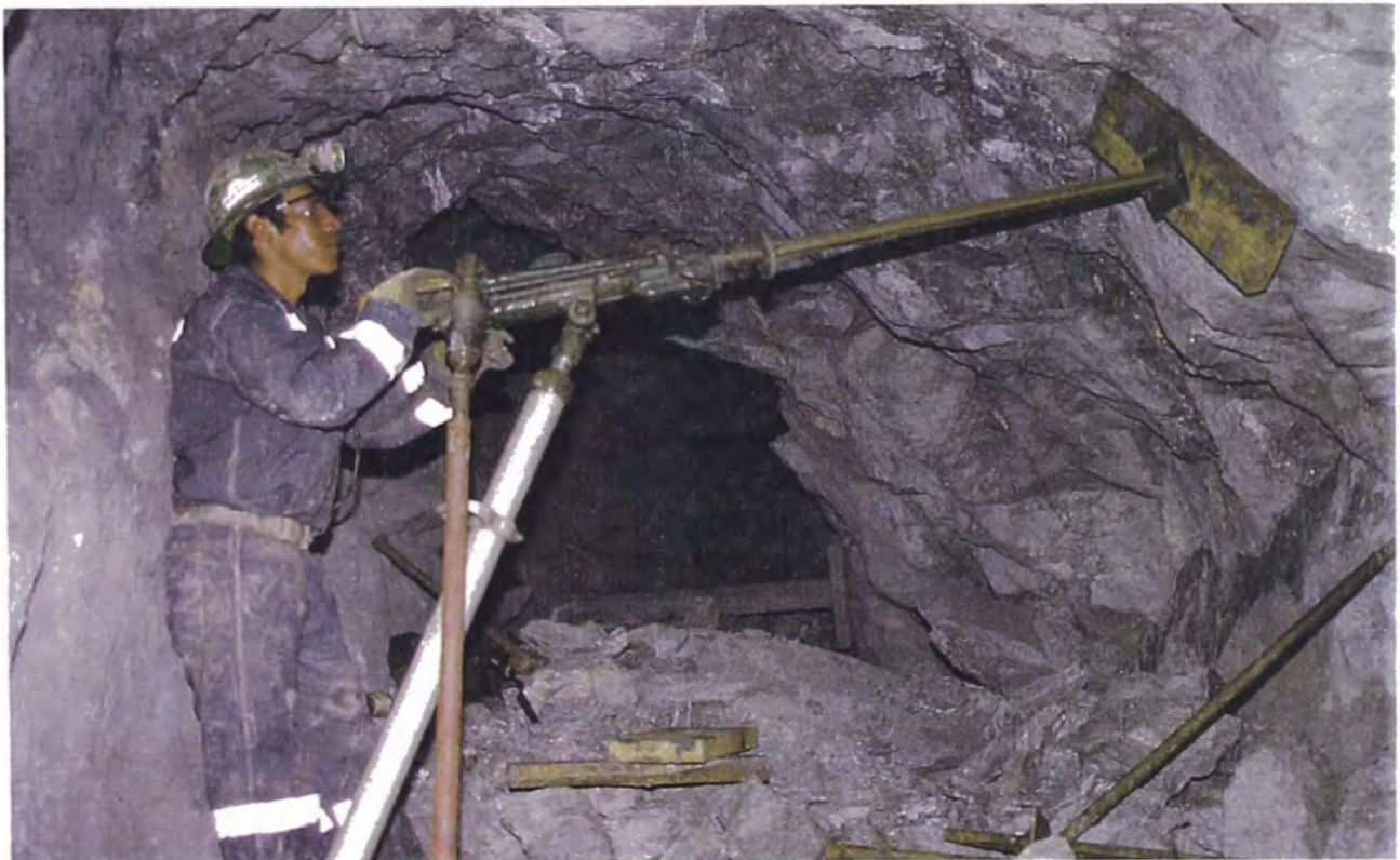
PERSONAL COLOCANDO SOSTENIMIENTO CON SPLIT-SETS EN TAJEOS
