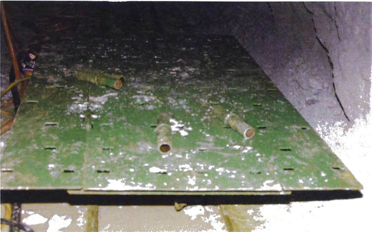
PLATAFORMA DE PERFORACION PARA EVITAR LOS LOMOS DE CORVINA
