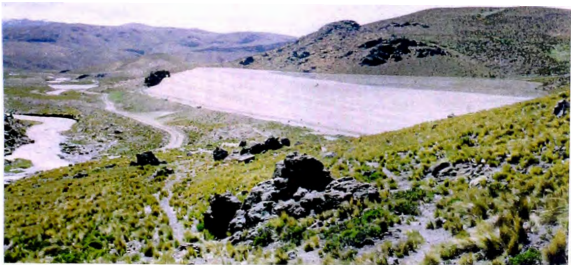
Cancha de relave No. 3, en actual operación
