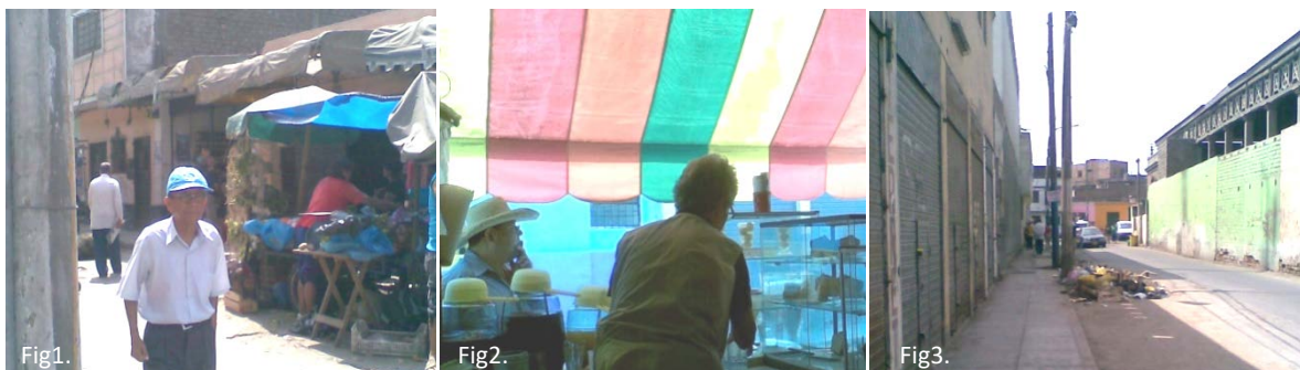
Fig1.Vista de comercio ambulante en el Pasaje Tumbes. Fig2. Vivienda en estado deficiente, realiza comercio desde su casa. Fig3.Edificio comercial abandonado, y Mercado de Limoncillo en estado deficiente. 40
