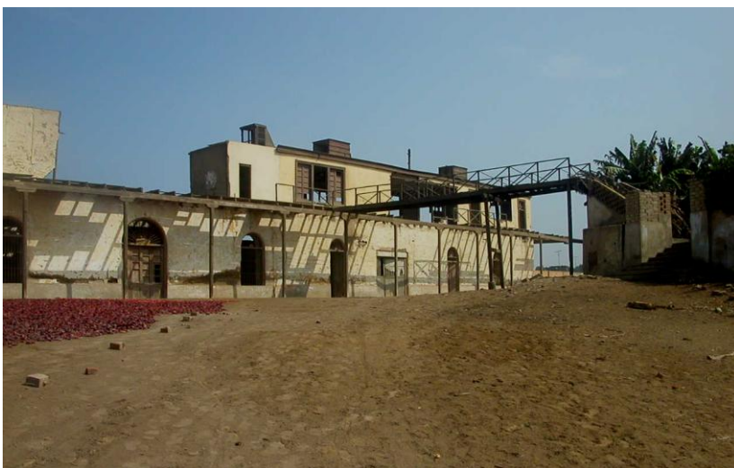
Aspectos parciales, vista desde el ingreso a la hacienda hacia el Directorio.
