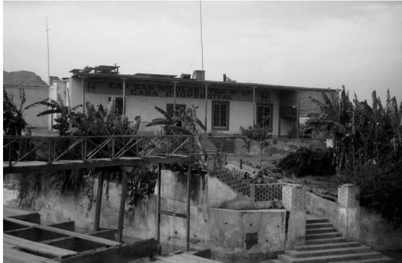
Foto externa de la Casa del Administrador desde el Directorio.
