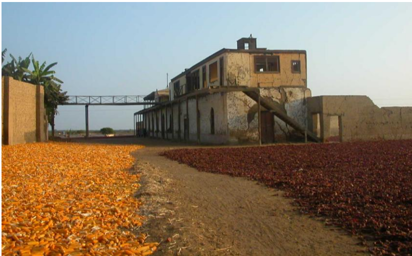
Aspectos parciales, apreciándose la vinculación mediante un puente peatonal de madera (existían dos) que une la casa hacienda con la residencia administrativa y otras dependencias.
