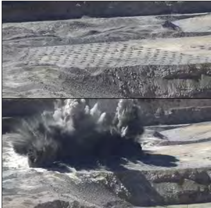
Figura N° 4.2: Muestra las operaciones binomiales de perforación y voladura (Fuente Mina Cuajone).
