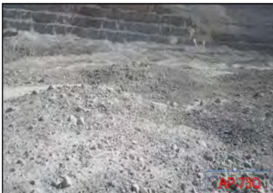
Figura N° 7.30: Muestra las imágenes post voladura con AP-73Q.
