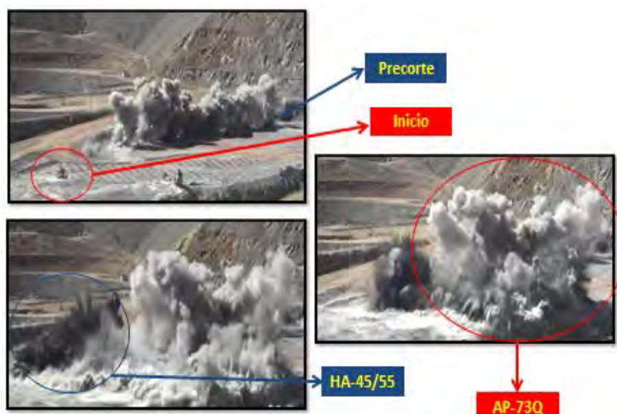
Figura N° 7.33: Muestra las imágenes de la Voladura con AP-73Q y ANFO pesado 45/55.
