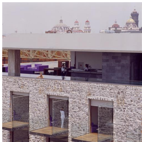
Fig. Vista del último nivel
