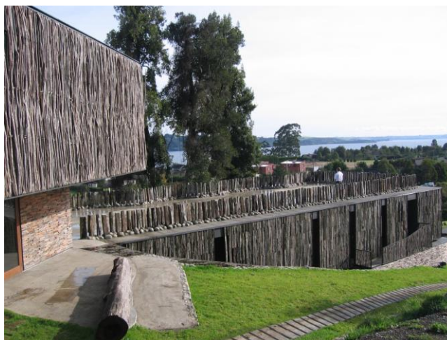
Fig. Vista desde la plataforma superior
