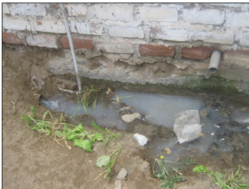
Foto N°2.0 Formación de canaletas para las aguas residuales
