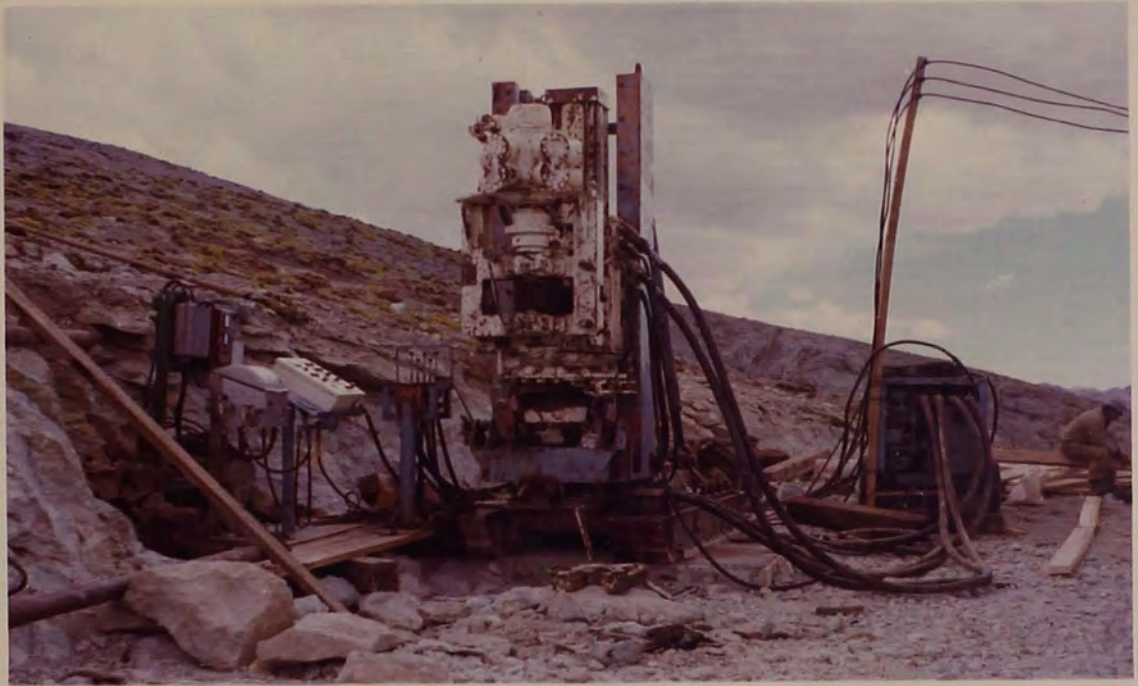
PERFORADOR GIRATORIO Y COLUMNA ESTRUTURAL
