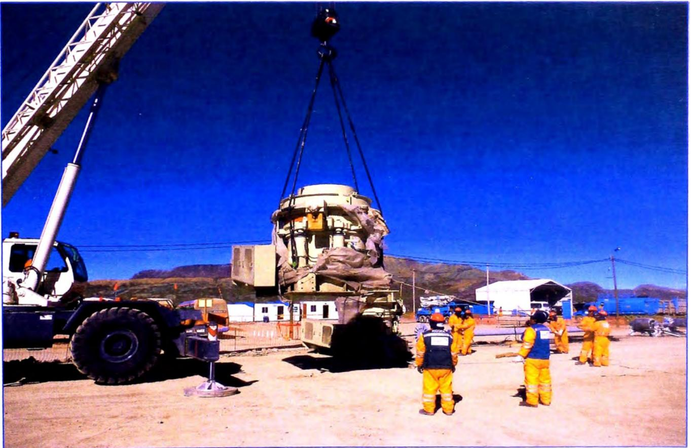
Figura 4.11 Montaje de la chancadora secundaria, traslado de almacén.
