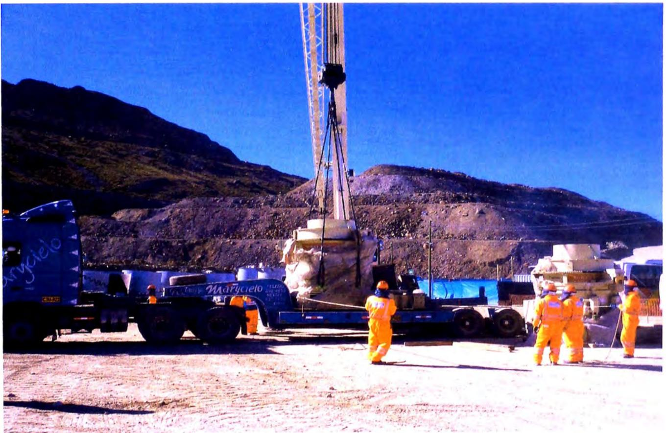
Figura 4.15 Montaje de la chancadora Terciaria, traslado de almacén.
