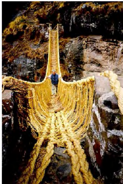
FIGURA N° 1-1: Puente colgante sobre el río Apurímac
