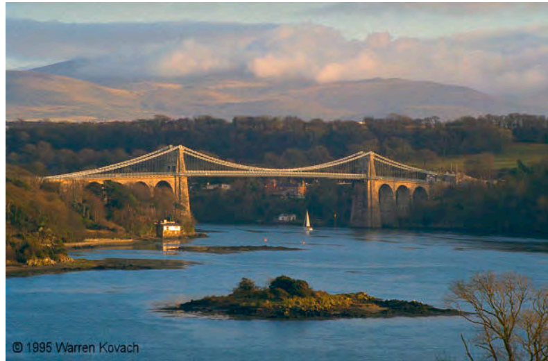
FIGURA N° 1-3: Puente colgante del Menai, Gales, 1826
