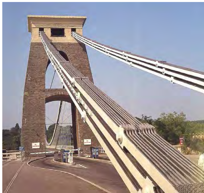
FIGURA N° 1-4: Puente colgante de Clifton, Inglaterra, 1864
