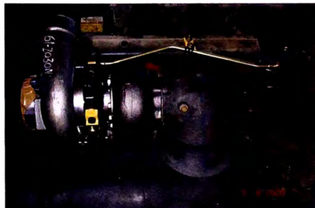
Fig.4.3 Instalación de líneas de refrigeración (turbocompresor).
