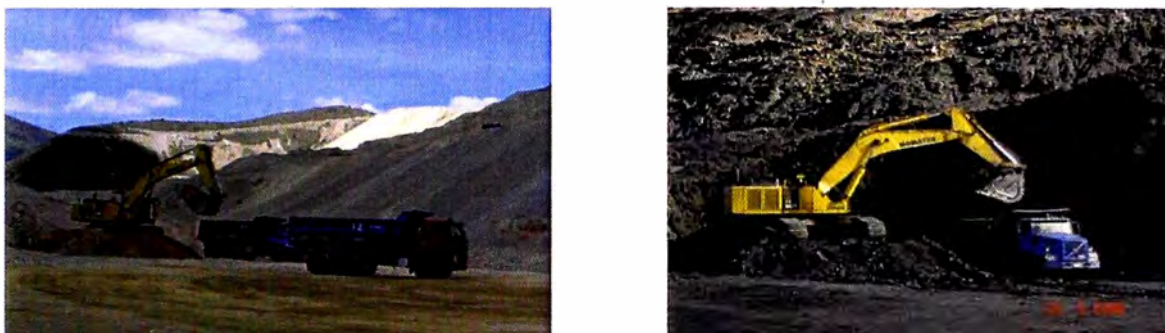
Fig. 2.1, 2.2 Excavadora en operación (sobre “cama de material”)
