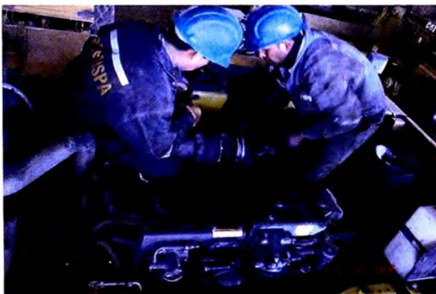
Fig. 4.2 Instalación del turbocompresor.
