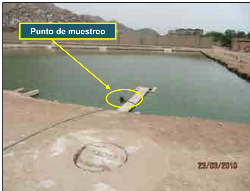
Figura 3. 36: Se muestra la captación para los sistemas por tandas y de flujo continuo (CITRAR-Año 2010)
