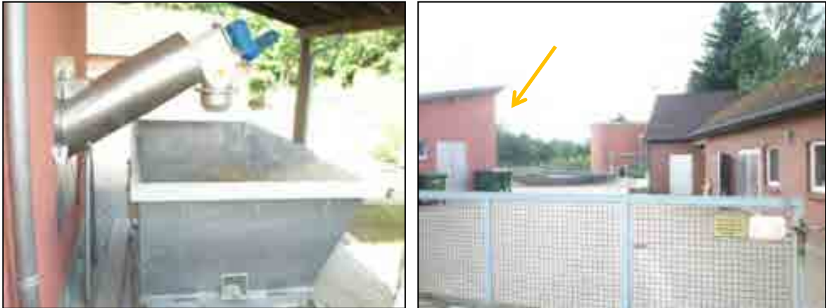
Figura 6: Se muestra a la izquierda la extracción de arena a un contenedor y a la derecha la caseta del sistema de pretratamiento de la PTAR de Suderburgo (Año 2009).
