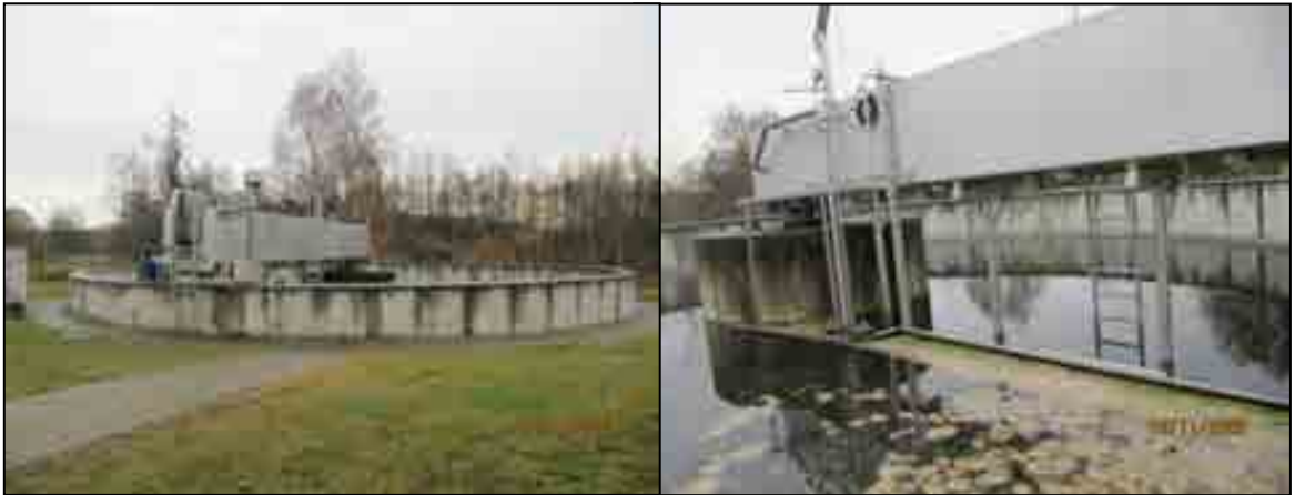
Figura 7: Clarificador Automático del Sistema de Lodos Activados, sistema final de la PTAR de la ciudad de Suderburgo (Año 2009).
