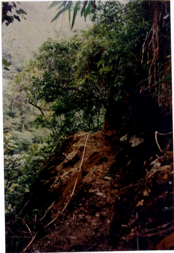
FOTO N°10: Talud de roca descompuesta, clasificada como roca suelta (A), ubicada entre las progresivas 0+800 - 0+900 de la Variante Chimay.
