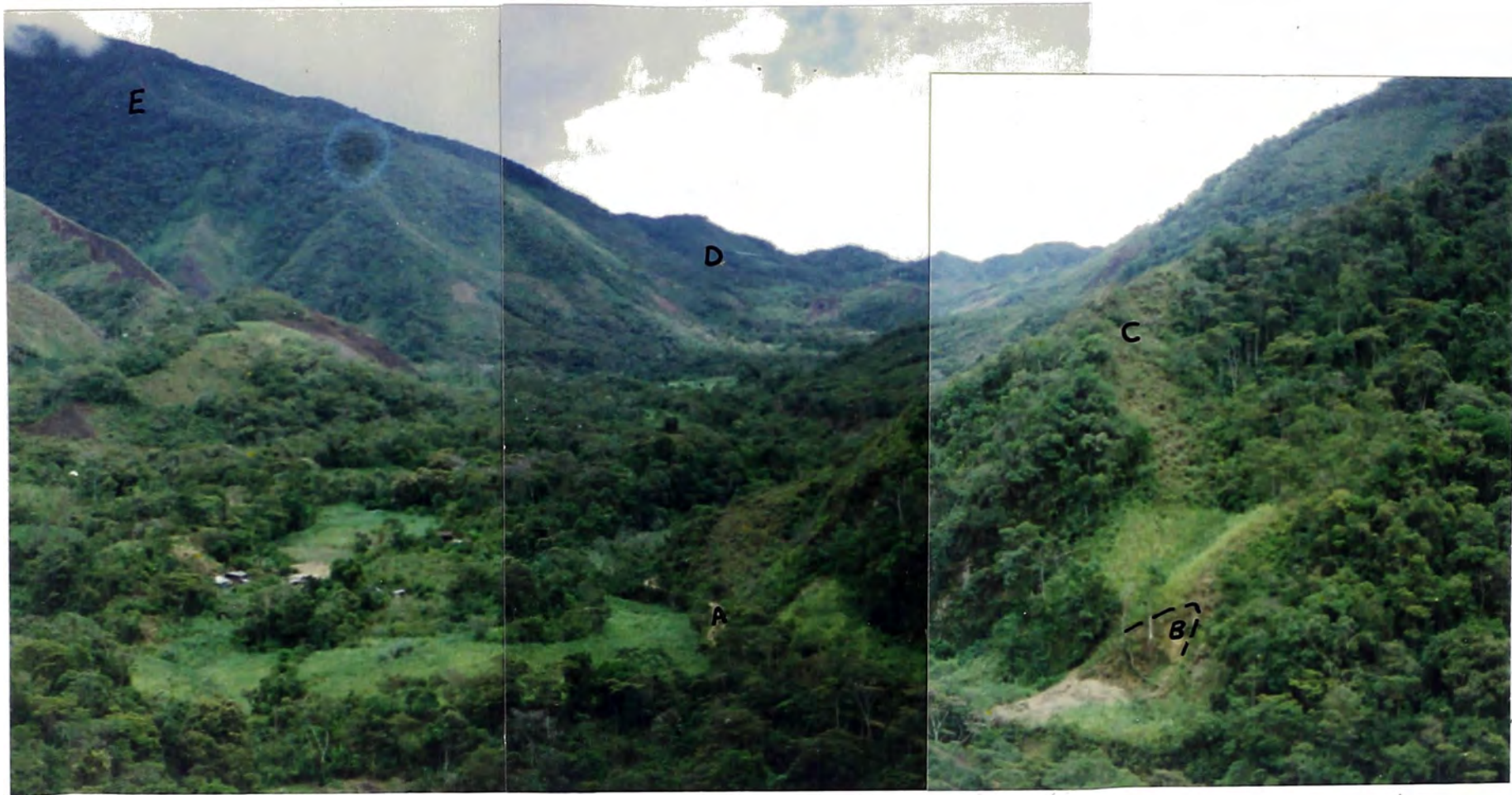
FOTO Nº 1: Vista de la Terraza Chacaybamba, formada por la acumulación de deslizamientos antiguos, Variante de Carretera Monobamba; progresivas 4+500 - 11+000, observándose tramo de la carretera actual a Chacaybamba (A) y un Deslizamiento de Suelo Residual (B), Afloramientos Graníticos (C), Afloramientos Grupo Mitu (D) y Afloramientos Grupo Pucará (E).
