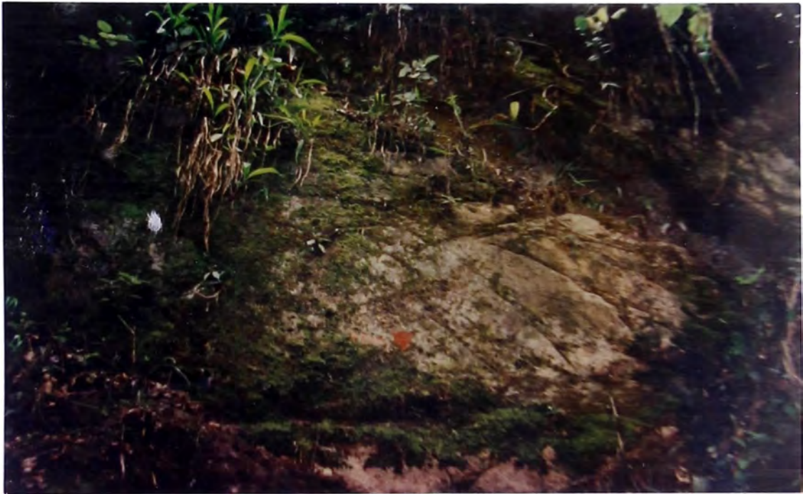
FOTO Nº 11 Talud de afloramiento de granito, clasificado como roca fija; progresiva 0+445 0+490, Variante Chimay.
