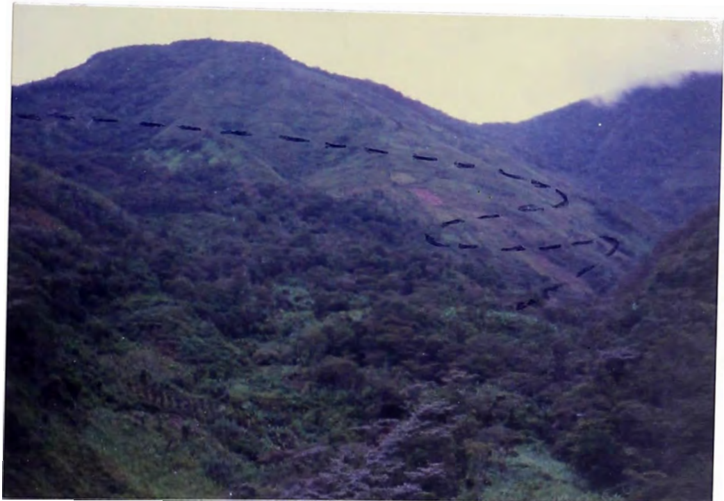
FOTO N° 4: Variante trazo Monobamba. Progresivas 3+800 - 2+000, en rocas del Grupo Mitu.
