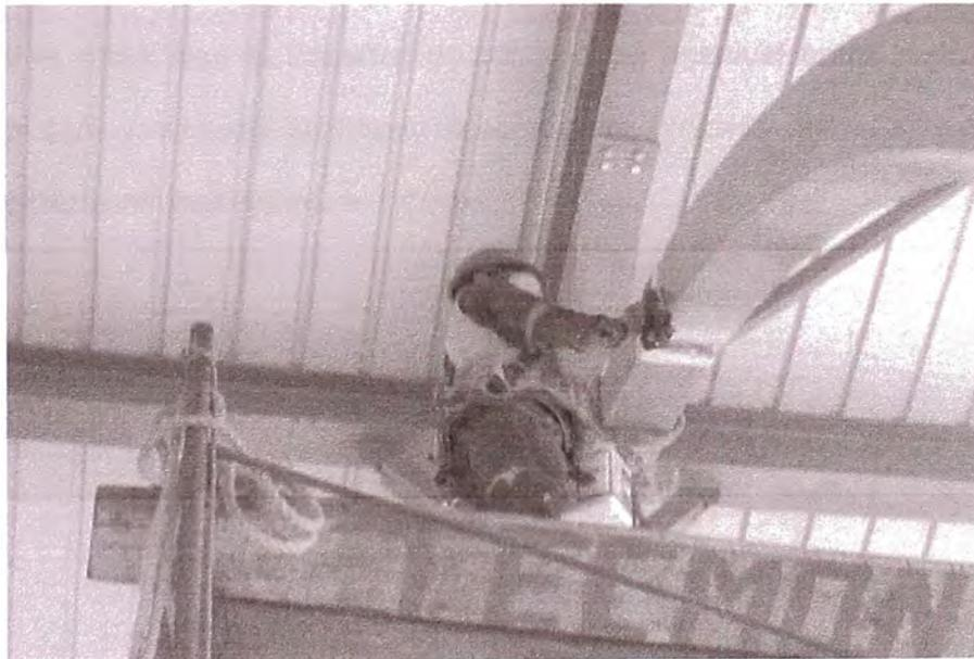
**FOTO 3.47** Limpieza de la zona soldada con Deterjet 20
