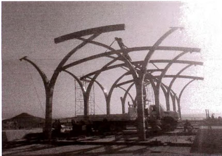
**FOTO 3.23** Montaje de vigas Curvas
