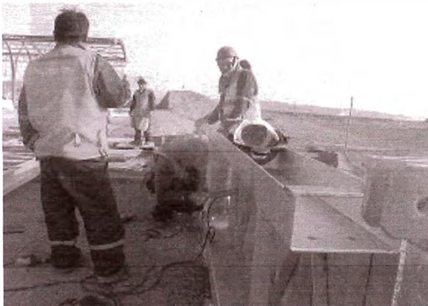
**Fijación de pisos mediante puntos de soldadura**
