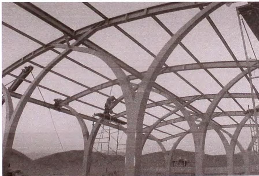
**FOTO 3.24** Montaje de Vigas Principales, Viguetas y Arriostres
