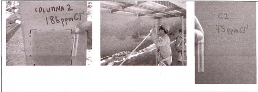
**FOTO 2.1** Limpieza con agua, detergente y trapo antes del chorro abrasivo
