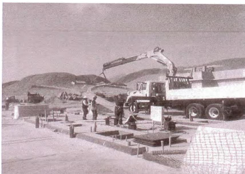
**FOTO 3.16** Elevación de Pórtico Eje 5
