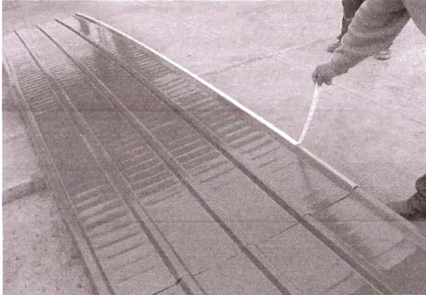
**FOTO 3.32** Colocación de cinta butil sobre cresta de traslape
