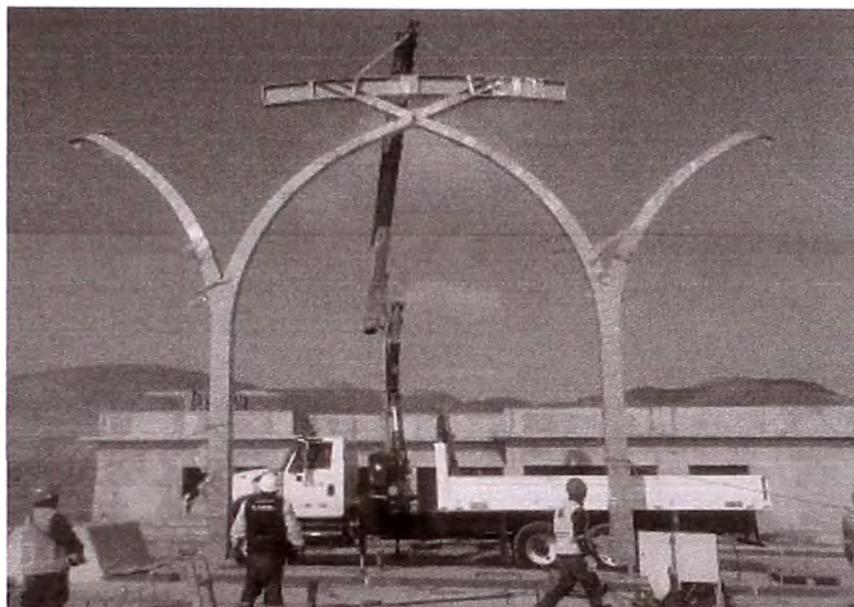
**FOTO 3.17** Pórtico Eje 5 en Posición de Montaje
