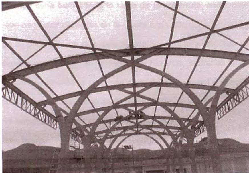
**FOTO 3.31** Montaje de estructura de frisos y arriostre de frisos
