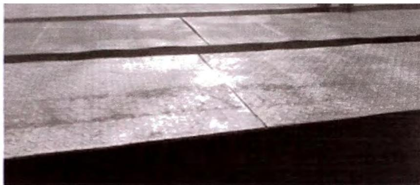
**FOTO 3.36** Planchas de plataformas de pasarela levantadas y deformadas
