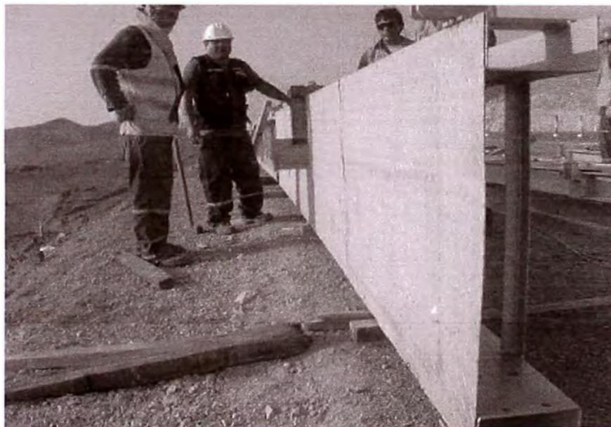
**FOTO 3.39** Planchas colocadas listas para soldar
