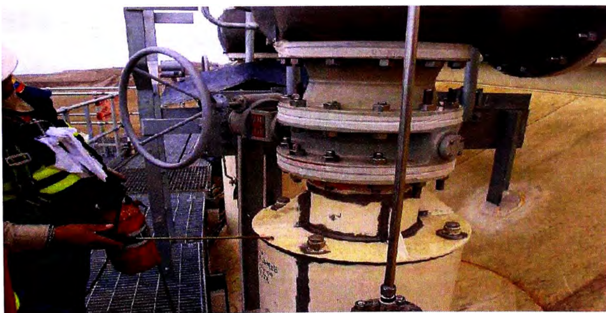
Chequeo de fugas en prueba neumática
