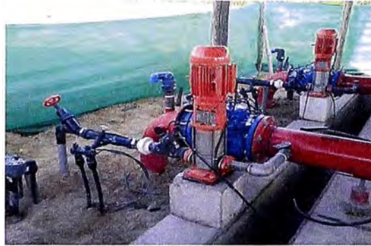
Figura 3.6 Sistema de inyección de fertilizante con venturi
