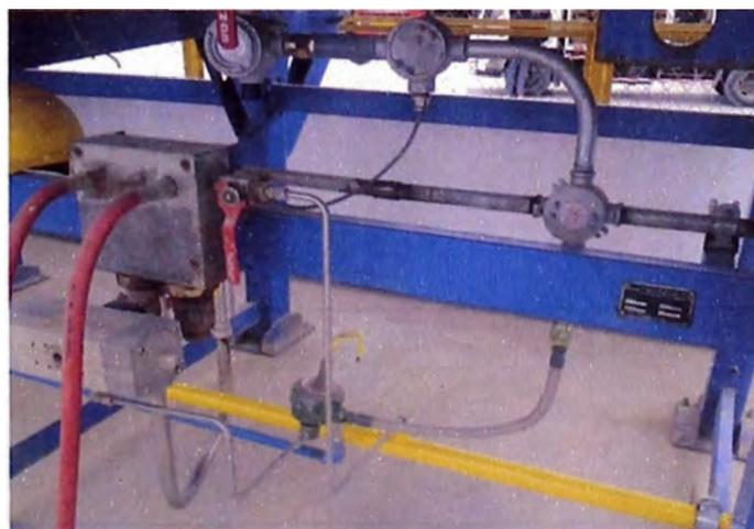
**Figura 3.38** Instalación de la instrumentación (válvula de comando, transductor de presión, detector de gas) para cada Módulo de Almacenamiento (MAT).
