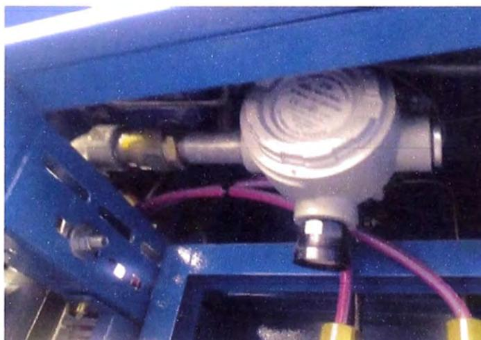
**Figura 3.40** Montaje e instalación de detectores de gas en Dispensador
