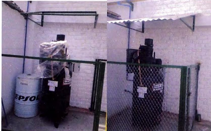
**Figura 3.25** Instalación de Compresor de Aire para válvulas comandadas.
