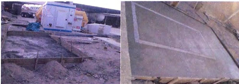
**Figura 3.12** Construcción de losa de Compresor de Gas
