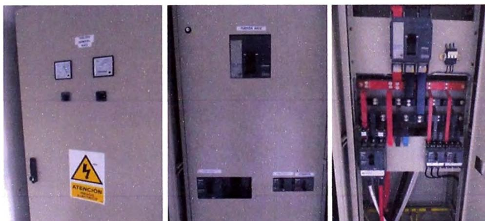
**Figura 3.20** Tablero de Distribución General en 440V
