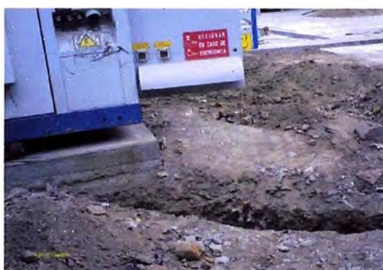
**Figura 3.18** Zanjas Eléctricas para acometida del Compresor de Gas
