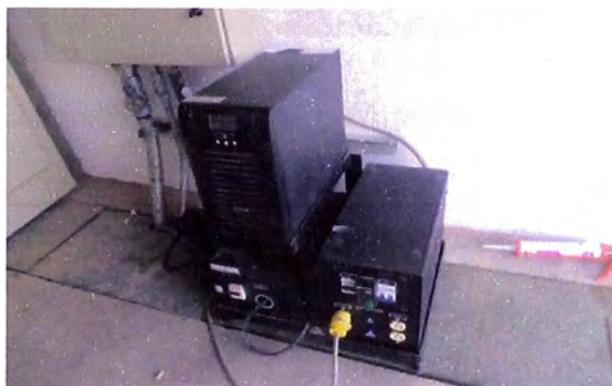
**Figura 3.23** Equipos electrónicos para energía estabilizada: UPS 3kVA, Transformador de Aislamiento y Banco de Baterías.
