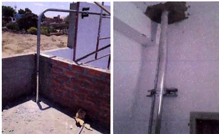
**Figura 3.26** Montaje de tubería conduit, ingreso a Sala de Sistemas
