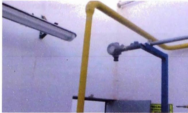
**Figura 3.36** Detector de Fuga de Gas de la PRC
