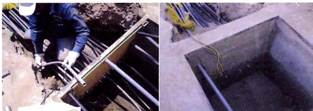
Figura 3.15 Distribución de tuberías para acometidas en Buzón Eléctrico
