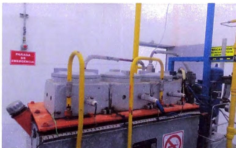
**Figura 3.34** Cajas Antiexplosivas para acometidas de resistencias 45kW.
