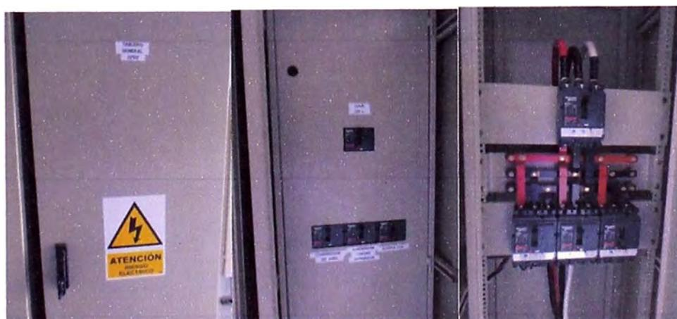
**Figura 3.21** Tablero de Distribución General en 220V
