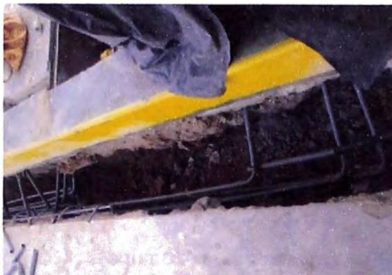
**Figura 3.17** Zanjas Eléctricas en Islas de Despacho de GNV
