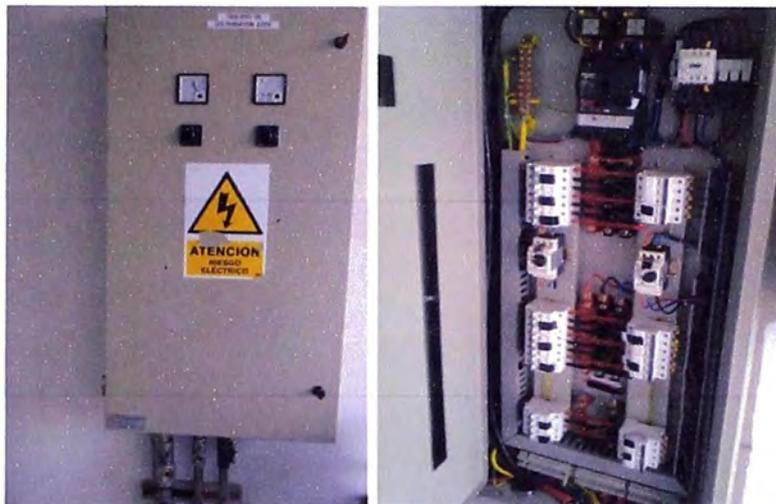
**Figura 3.22** Tablero de Auxiliares
