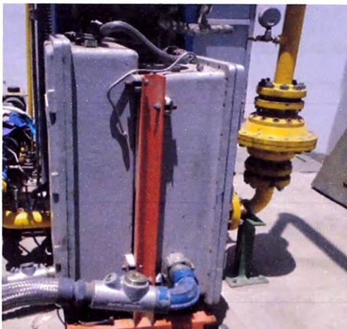
**Figura 3.43** Planta Reguladora Compacta Instalación Final.
