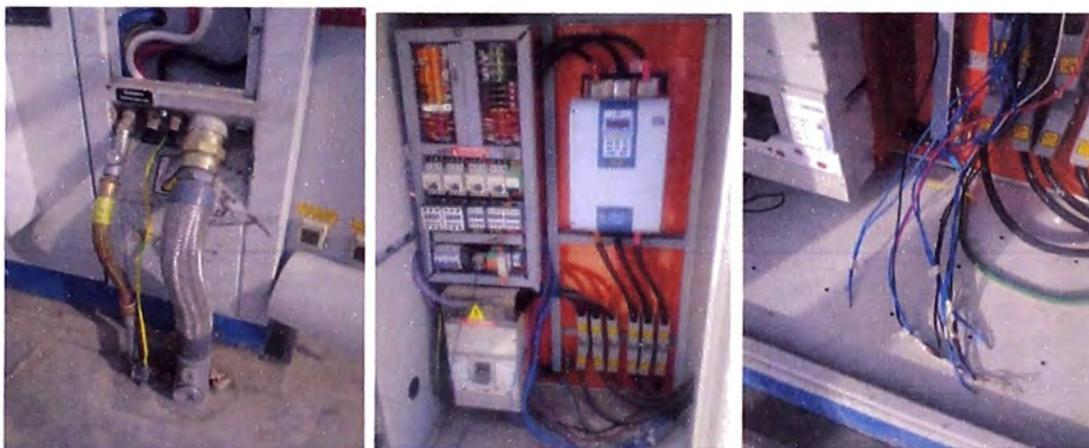
**Figura 3.31** Acometida eléctrica y cables de llegada del Compresor de Gas
