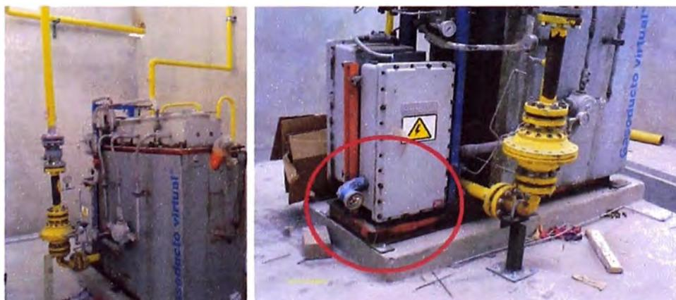
**Figura 3.32** Planta Reguladora Compacta sin acometida.
