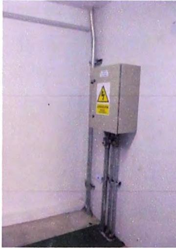
**Figura 3.27** Instalación y conexión de tablero de Energía Estabilizada.
