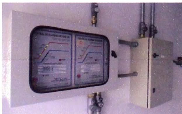
**Figura 3.24** Equipos electrónicos: Central de Detección de Gas.
